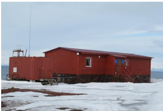
Arbeidspaviljong og en driftsteknisk konteiner
