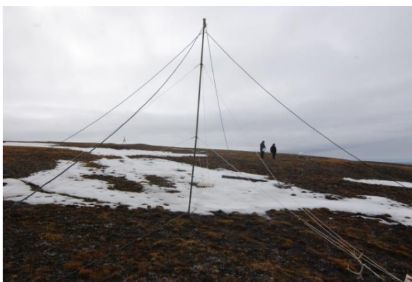
Antenne for mottak av ekstra lavfrekvente bølgebånd
