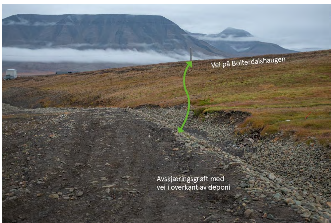
Figur 10 Foto fra avskjæringsgrøfta mot Bolterdalshaugen med forslag til trasé som forbinder eksisterende veier.
