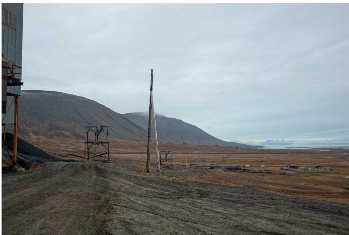
Figur 11 Foto fra Gruve 6 dalstasjon mot Longyearbyen. Et flott overblikk over taubaneanlegget og dalen.
