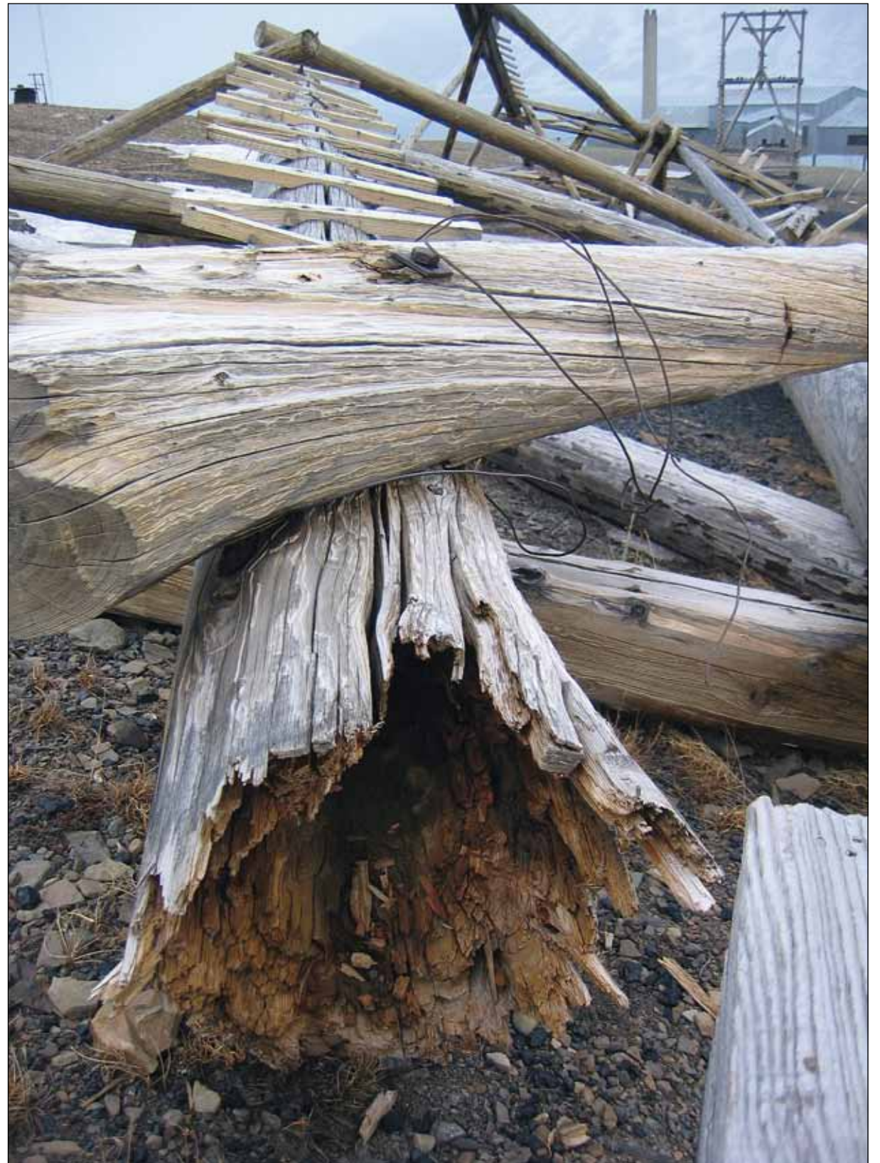
Taubanebukkene i Longyearbyen er en viktig del av byens gruvehistorie og bybildet med høy verneverdi. Mange av disse er i ferd med å råtne. Her fra en nedrast taubanebukk (nr. 23), taubanelinje 1b. Som bildet viser, var den svært råttent innvendig.
