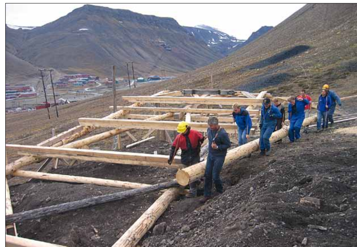
Sysselmannens sterke menn på tømmerbæring. Fire hovedstokker og midtstilt boks bæres til rett posisjon på bukkens andre hoveddel. Rekonstruksjon av nedrast taubanebukk (nr. 23), taubanelinje 1b, Longyearbyen.
