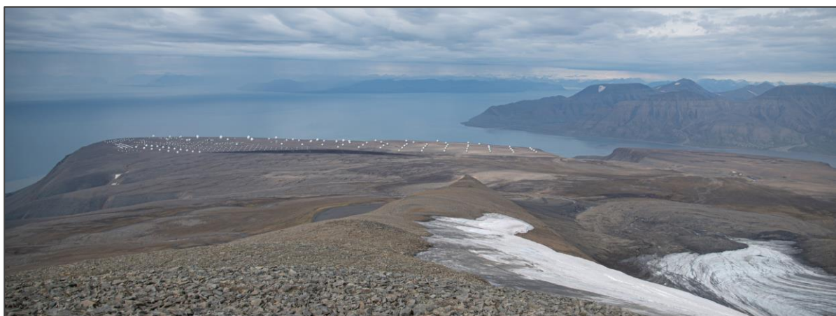
Figur 9-11. Manipulerte bilder fra veien opp til Nordenskiöldfjellet viser 0-alternativet som vist i plan øverst og tilsvarende for planlagt utvidelse nederst. Sett i et fugleperspektiv, er dette det området der den visuelle endringen vil oppleves som størst. Spesielt solcellepanelene blir med sin mørke farge en markant strek i landskapsbildet. Foto: LPO Arkitekter.
