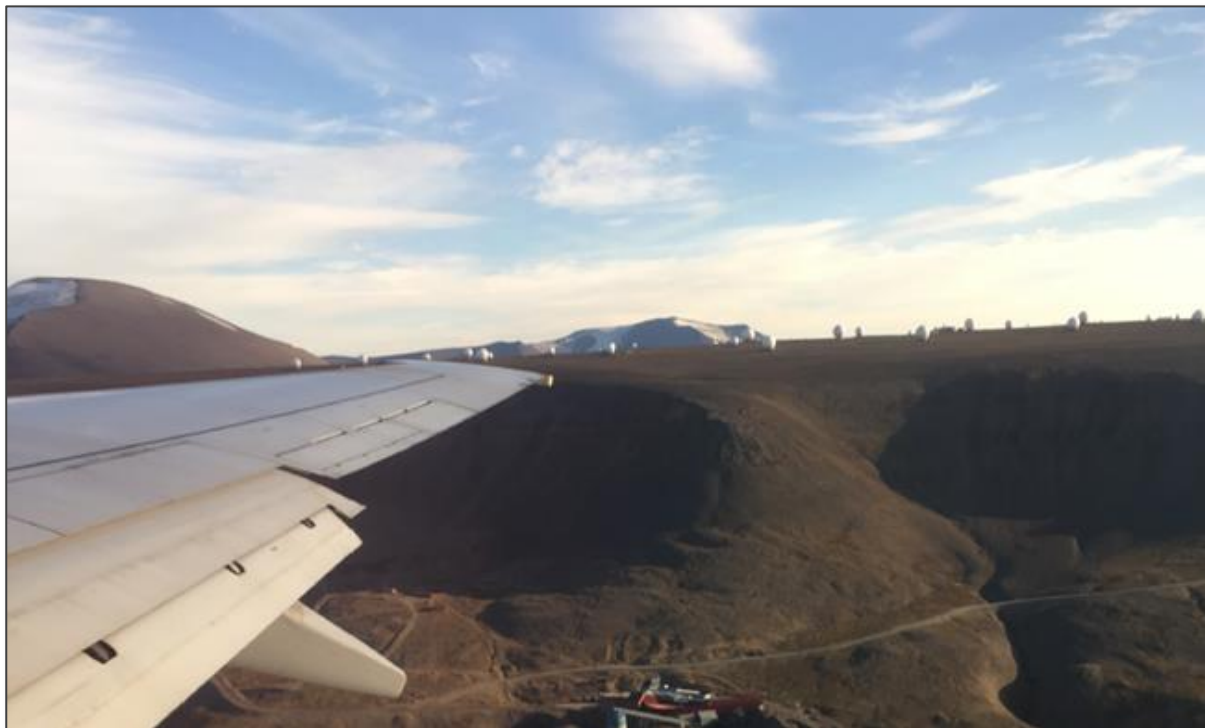
Figur 18-3. Ved innflygningen til Svalbard ser man både Gruve 3, og SvalSat sitt anlegg på Platåberget. Kilde: LPO Arkitekter.
