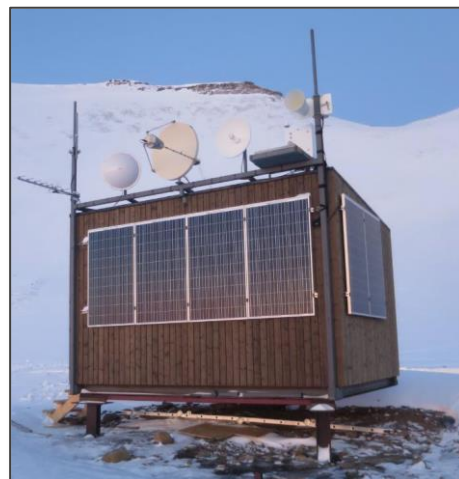
Figur 2-2. Bildet viser dagens boresight på Hiorthfjellet. Kilde: LPO (2020).
