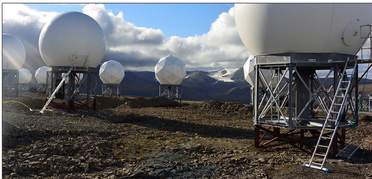
Figur 9-21. Ved oppføring av små antenner bør man vurdere ulike løsninger for etablering for å se om det er praktisk gjennomførbart med løsninger som bedre ivaretar polygonmarka.
