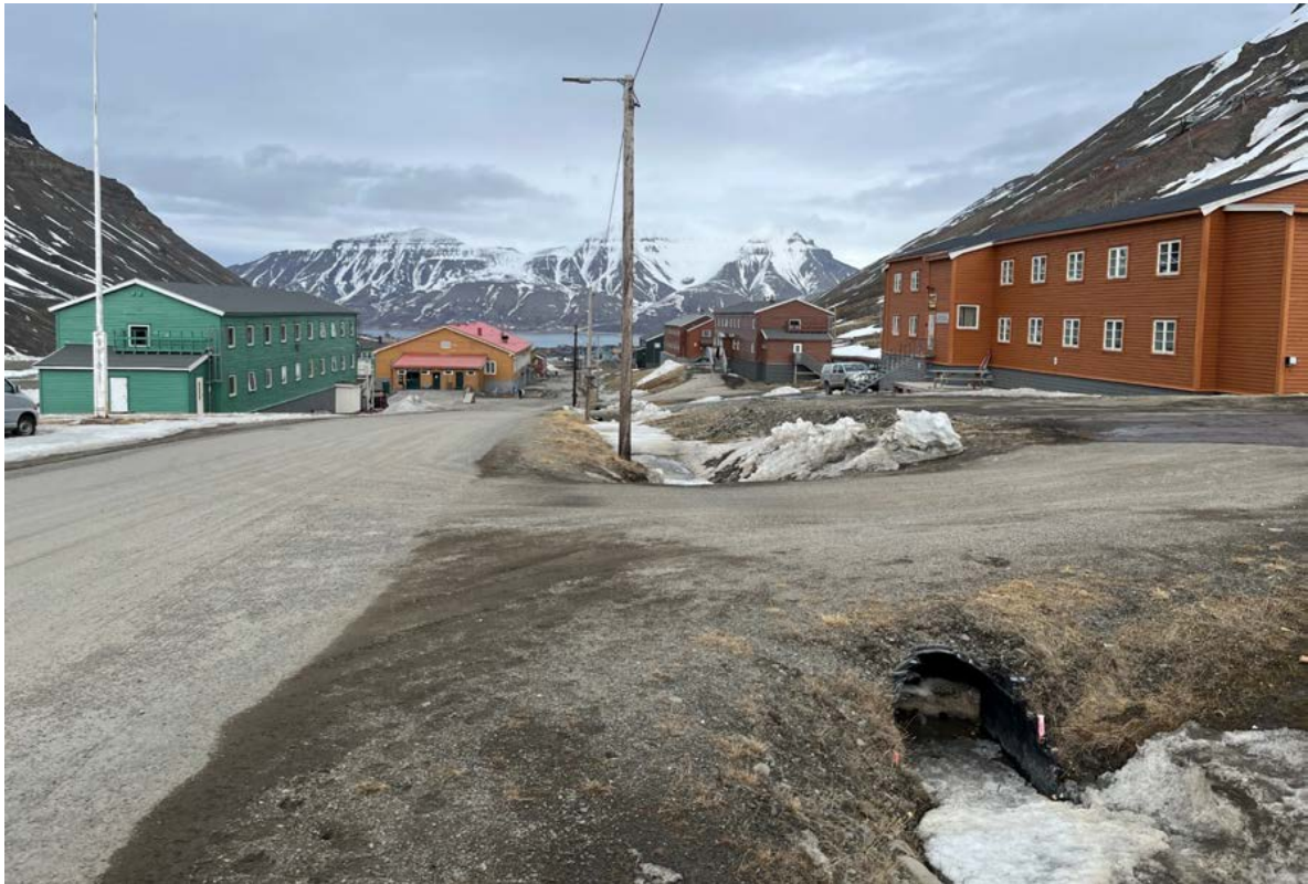
Vei 100 går som en tilnærmet rett linje gjennom Nybyen, med brakker på hver side og betydelig terrengfall mot nord. Små stikkveier går inn til hver enkelt bygning, dels med mindre parkeringsplasser. Drensgrøft med stikkrenner.
