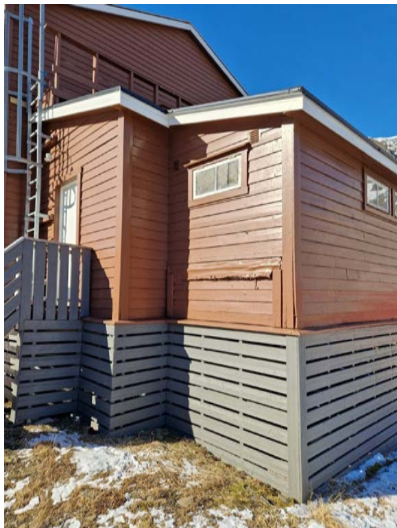
Opprinnelig utbygg i to etapper mot nord. Trolig rester etter luke for tømming av bøttdoer. Eldre vinduer er bevart.
