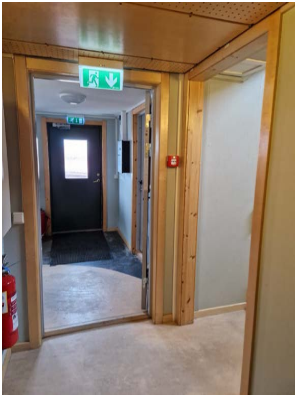
Mot hovedinngang i utbygget mot nord. Trapperom inn til høyre.
