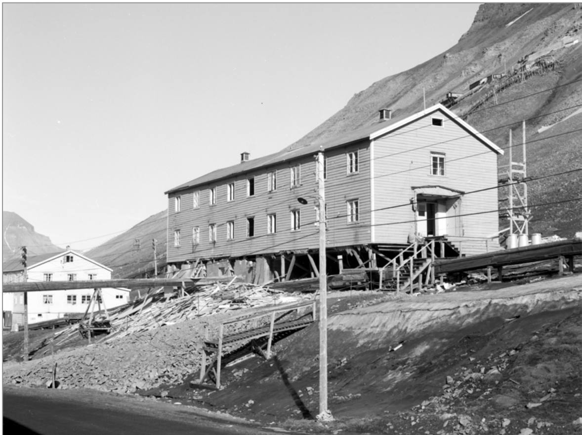
Opprinnelig fasade mot veien, ni vindusakser. Bygningen er under ombygging, antatt 1970–74. Bislaget mot sør er revet, noen vinduer er tatt ut, betongkjelleren har rivingssår, materialer ligger på bakken, og stillas er reist i øst. Foto: Herta Grøndal Lampert © Grøndal Foto (beskåret topp/bunn)
