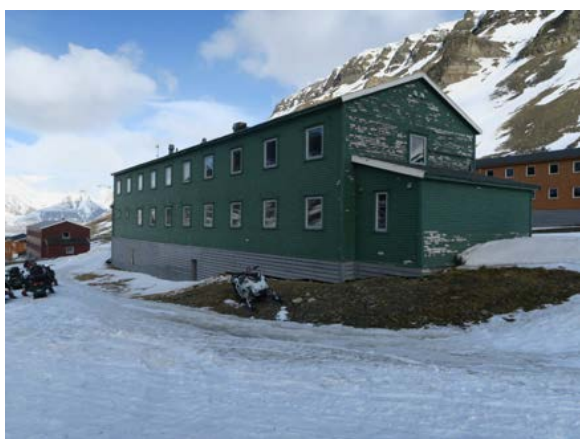
Langvegg mot vest og gavl med utbygg mot sør.
