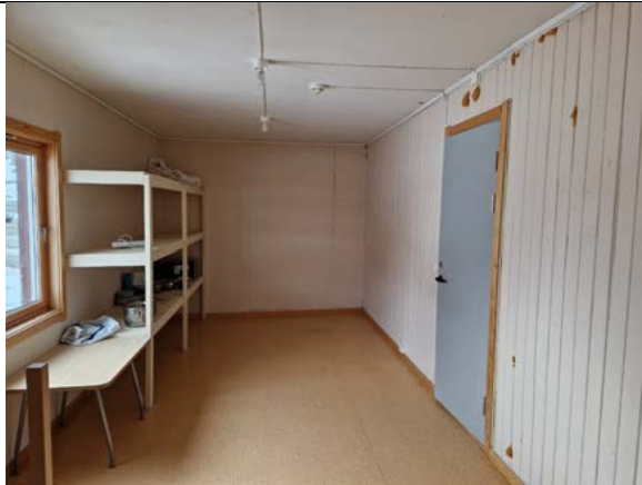
Opprinnelig utbygg mot sør. Trolig opprinnelig faspanel på vegg.
