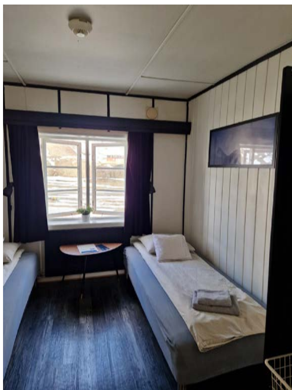
Hotellrom standard. Eldre platekledning er bevart på vegg og himling.
