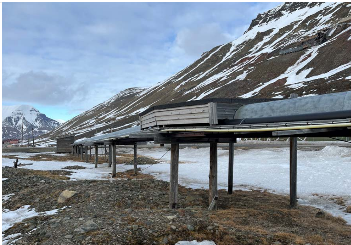
Rørgata sør for Pumpehuset (som skimtes bak til venstre) er overdekket med bøyde stålplater. Lite overbygg/vinkel kledd med liggende kledning og papptekket «tak», på tradisjonelt vis.
