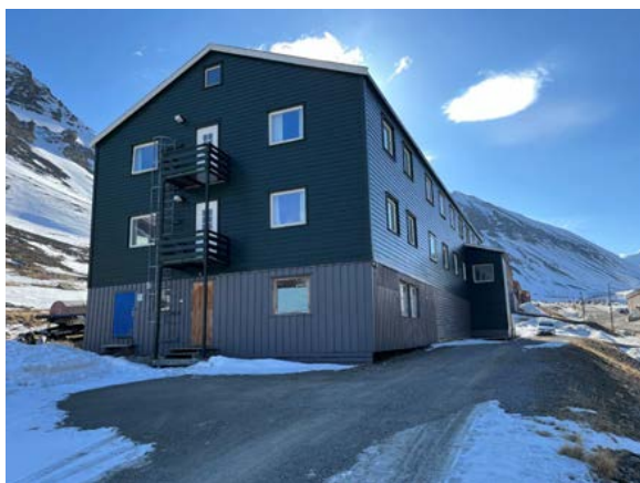
Bygningen fra nordvest. Atkomstveien går i en halvbue opp til platået foran Formannsmessa.
