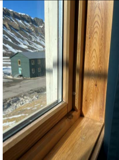
Typisk isolerglassvindu, antatt 1990-talls eller nyere.
