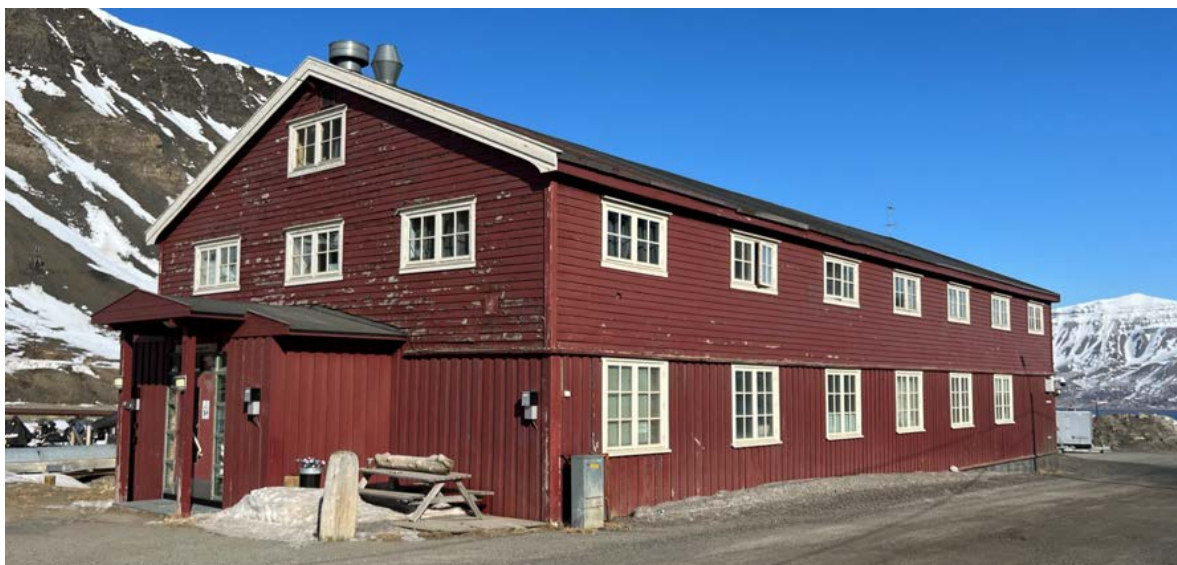
Opprinnelig inngang mot sør har fått et ekstra takutbygg og ny dør. To store vinduer er fjernet i 1. etasje.
