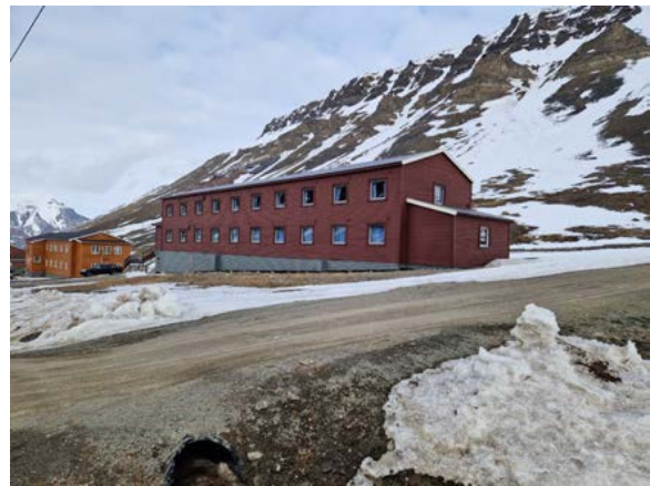
Langvegg mot vest og gavlfasade med opprinnelig tilbygg med pulttak mot sør.
