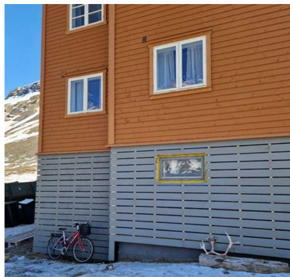
Vestfasade og nordre del. Synlig betongvegg fra tidligere fyrrom som forsvinner bak nytt skjørt.
