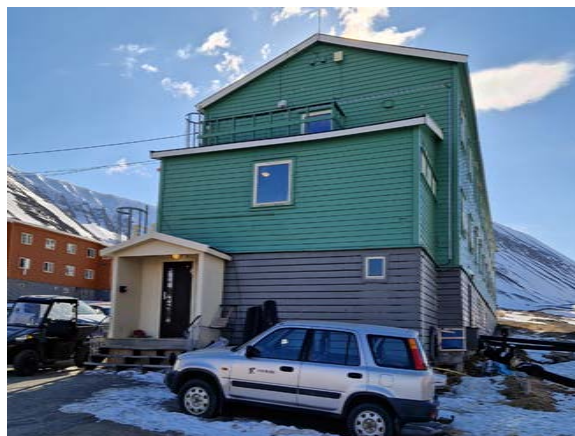
Opprinnelig utbygg mot nord. Nyere hovedinngang med bislag/saltak ble etablert tidlig på 1960-tallet.
