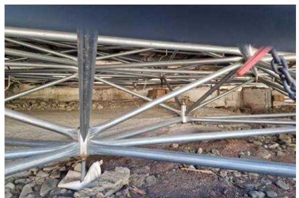
Stålfagverk, Triodetic. I bakgrunnen ser vi betongrester fra opprinnelig støpt fyrrom.
