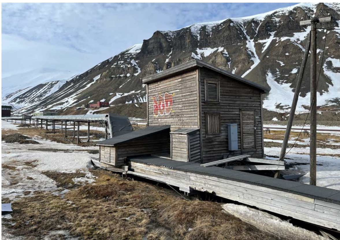
Anlegget sett fra nordøst (ca. krysset Vei 101 og Vei 301). Mot nord er det bevart en eldre rørgate med firkantet innkassing av tre, tradisjonell utførelse. Nyere papp som sikring på «taket» av rørgata.
