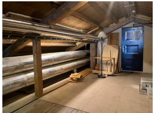
Langsgående stolper/dragere (tradisjonelt kalt stol) på hver side under taksperrene.
