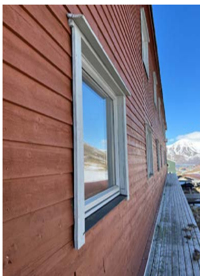
Utlektet kledning og dypere vindussmyg mot øst.
