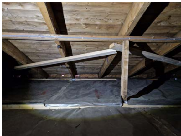
Nyere kryssavstivning av takflate er lagt inn på sperrer i nordenden av bygget.
