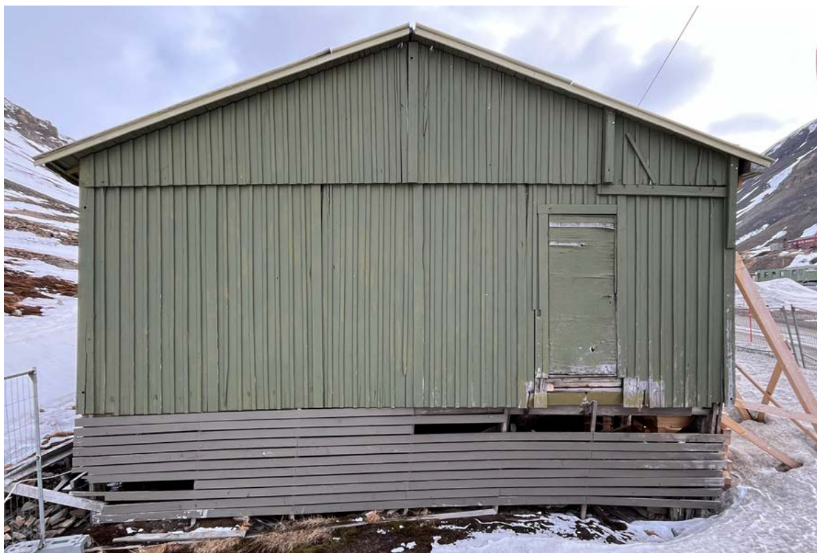
Fasade nord. Bredere dekkbord foran hver prefabrikkerte lem. Hver lem er i full vegghøyde (1. etasje).
