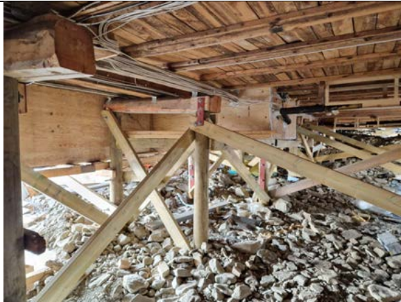
Tidligere peler er erstattet med nye i impregneret trevirke.
