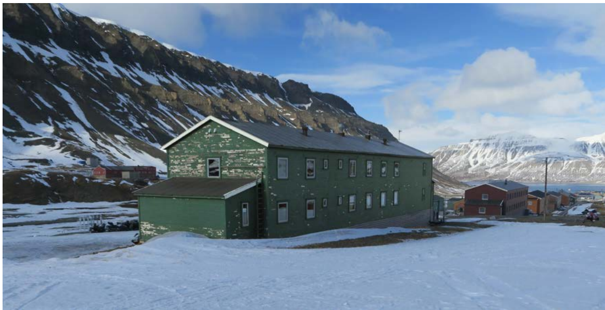
Vei 100-11 brakke 106, sett fra sørøst. Opprinnelig utbygg med pulttak mot sør.
