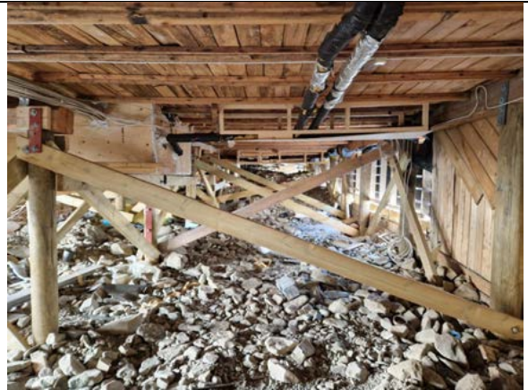
Nye peler. Til høyre ses skråstilt panel som opprinnelig ble spikret rett på bindingsverket, og dannet underlag for ytre supanel.
