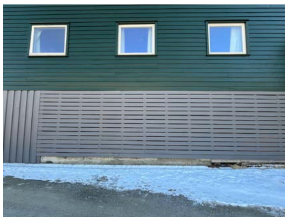
Fasadeutsnitt mot vest. Bak skjørtet ses nedre del av opprinnelig støpt kjeller (tidligere fyrrom).
