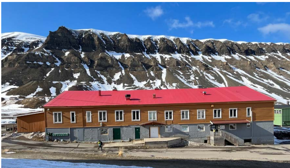
Fasade mot veien i øst. Bygningens karakter med støpt kjelleretasje og liggende panel på hovedetasjen er som opprinnelig. Vinduene er skiftet til moderne sprosseløse typer. Noen vinduer er endret i format og redusert i høyden, spor ses i kledningen. Bevart eldre lasterampe midt på fasaden. Tilbygget inngangsparti mot sør fra 1977.
