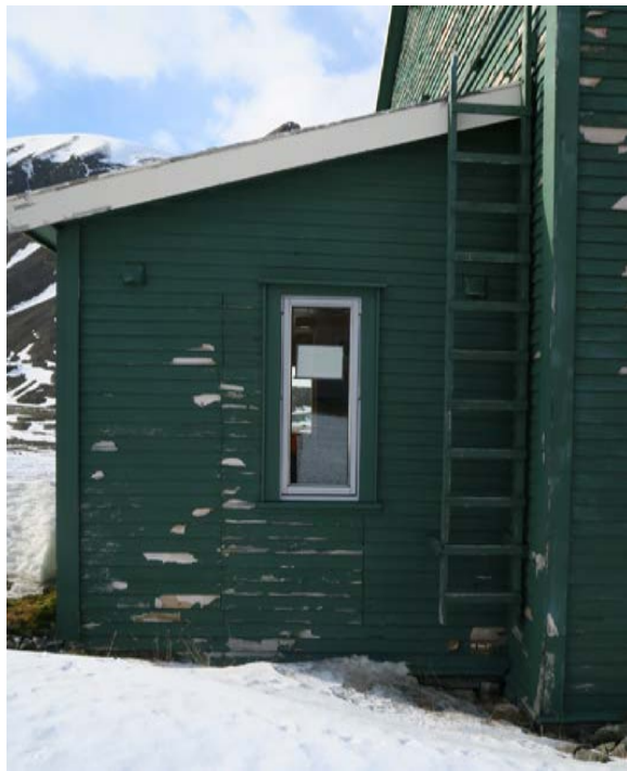
Østfasade på opprinnelig utbygg mot sør. Vindu har erstattet dør, spor etter panelskjøt ses tydelig.
