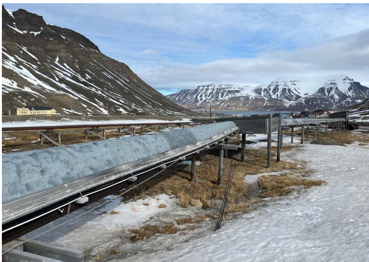
Rørgata sett mot nord, med Huset bak t.v. og Pumpehuset bak t.h. Parallet vest for rørgata ligger den nyere rørgata som går opp til det nye fyrhuset, som ble oppført i 1974.
