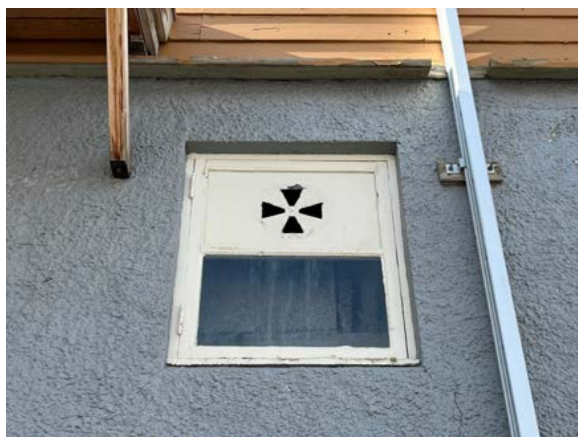
Ett opprinnelig vindu med integrert ventil er bevart mot øst.
