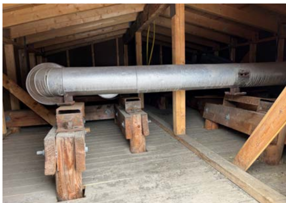
Inne ser vi toppen av de gamle pelerefundamentene. Tregulv og deler av konstruksjonen er eldre.
