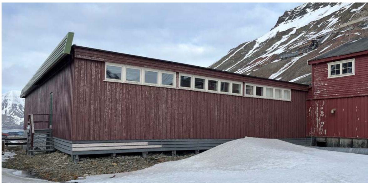
Fasade sør med opprinnelig vindusbånd og gesimskasse av liggende bord. Fasaden mot vest, og øvrige fasader, har nyere ytre gesimskasse av stål. Gamlebutikken til høyre og Gruve 2B i fjellet i bakgrunnen.
