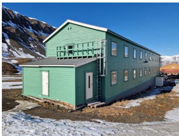
Opprinnelig utbygg mot sør og langvegg mot øst. Mot øst er ti opprinnelige vindusakser bevart.
