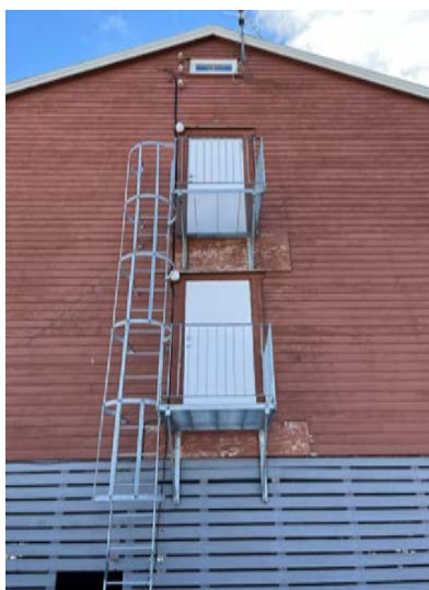
Rømningsstige mot nord, dørene ble etablert i 1970–74.
