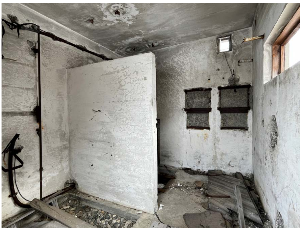
Interiør sett fra døråpningen i nord. Betongveggene er isolert med treullsement.
