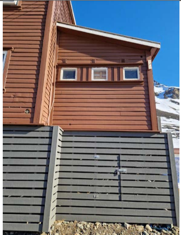
Opprinnelig utbygg mot sør. Karakteristisk eldre vindusbånd som går igjen på flere utbygg til andre brakker, etablert senest 1961. Skjørt utenfor vegglinn på grunn av nytt fundament.
