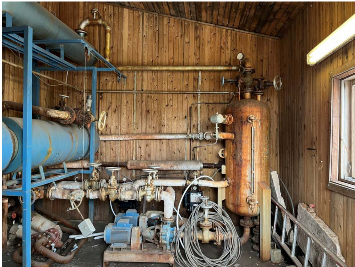
Interiøret sett fra døra i nord. Blå varmevekslere til venstre. Pumpene (midt i bildet) ble produsert i Oslo av «Hans Lindflaten AS» i 1976. (ref. Svalbard museum). Tanken til høyre ble brukt til trykkutligning.
