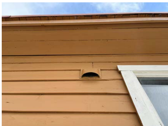
Over innkasset gesims ses opprinnelig taktro av stående bord. Flere opprinnelige/eldre ventiler er bevart, her på fasade vest.
