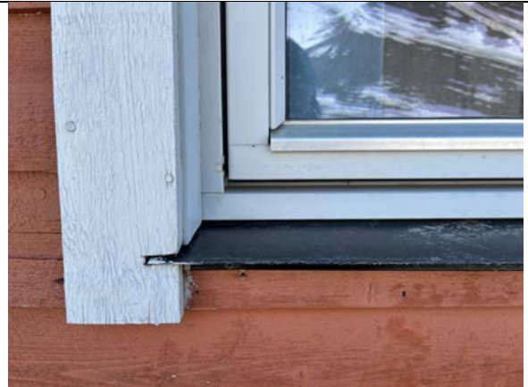
Detalj av typisk vindu med moderne detaljer, fornyet på 1990-tallet.
