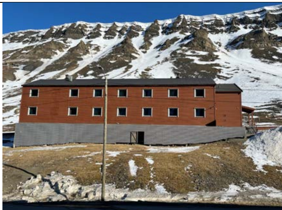
Fasaden mot veien fikk åtte vindusakser etter ombygging i 1970–74. To vinduer er senere kledd inn mot badene, som ble innredet i opprinnelig bitrappesrom.
