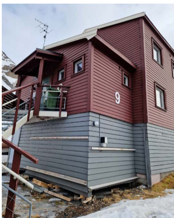
Tilbygg mot nord har fått erstattet pulttak med saltak. Nyere skjørt av liggende bord.
