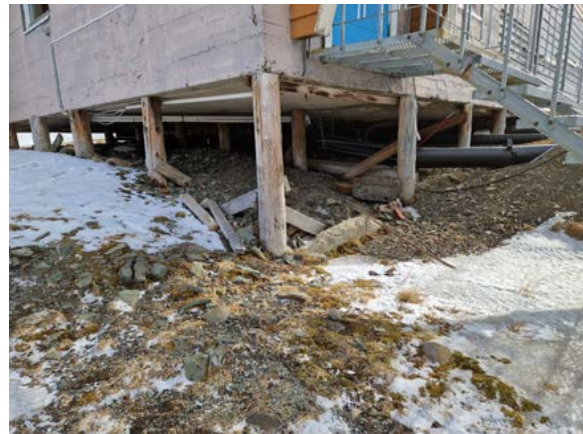
Pelefundament under betongvegger i fyrrom. Dekket er av støpt betong isolert med Siporex-blokker på undersiden mot terreng.
