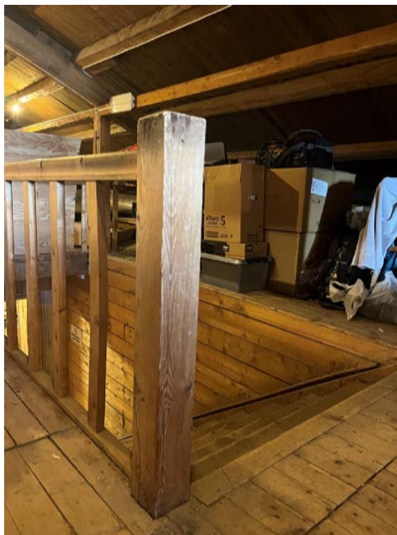
Opprinnelig rekkverk ved trapp på råloftet.
