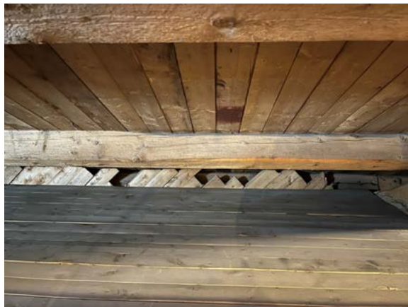
Opprinnelig skråstilt kledning på utsiden av bindingsverket i yttervegg. Takåser/taktro over.
