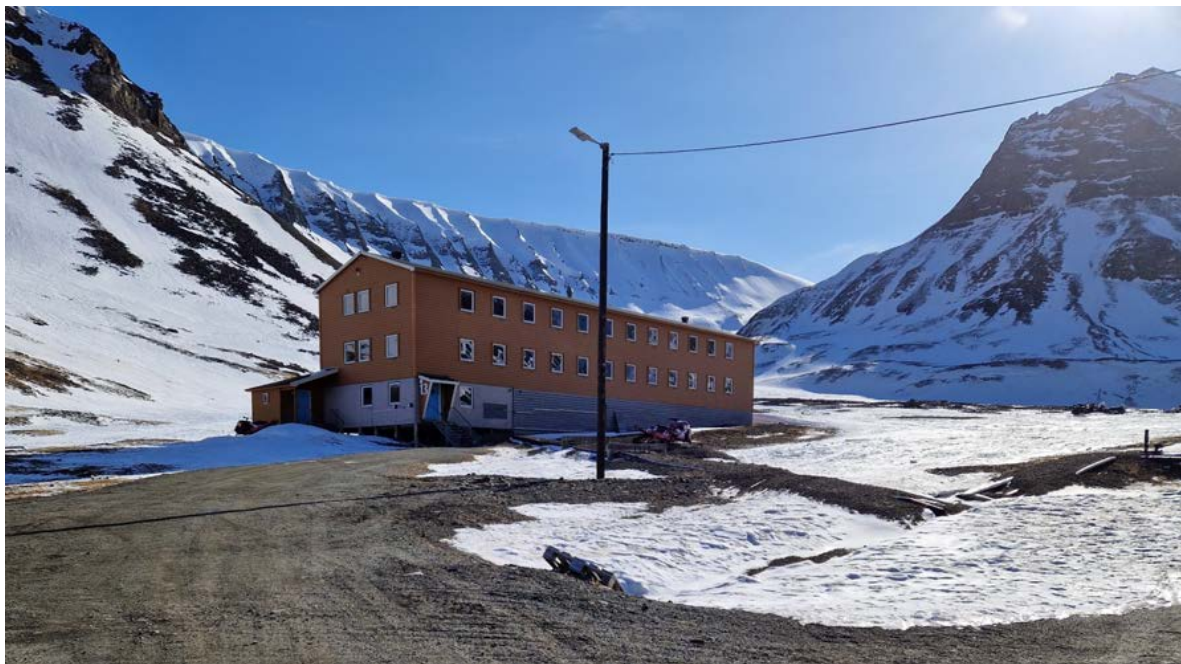
Vei 100-13 brakke 115, sett fra nordvest. Brakka ligger helt i utkanten av Nybyen, som eneste bygning øst for den opprinnelige rekka med brakker langs hovedveien.
