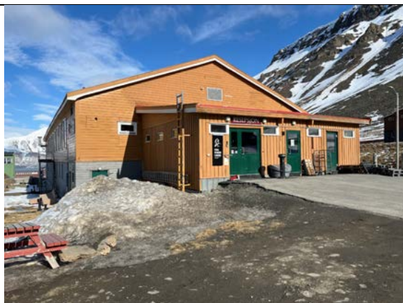
Fasade sør med inngangsparti fra 1977, senere noe ombygget.
