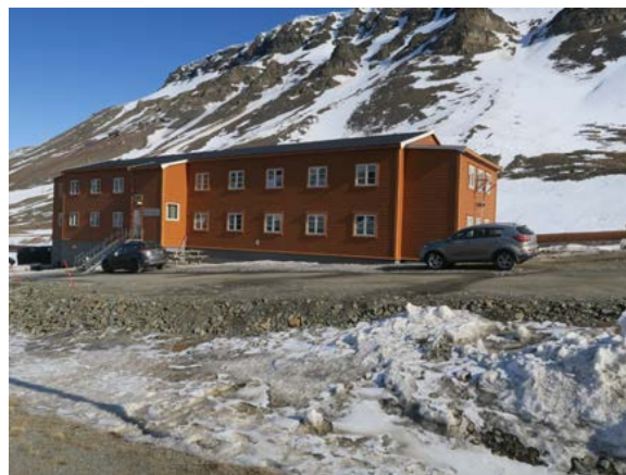
Vestfasade med inngangstilbygg fra 1974.
