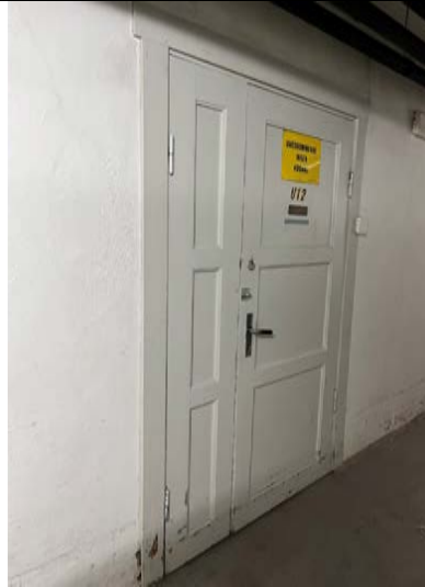
Eksempel på eldre fyllingsdør i kjeller.
