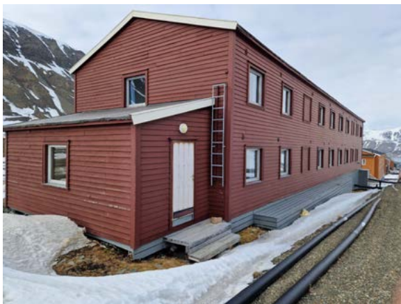
Opprinnelig tilbygg mot sør og langvegg mot øst. Utstikkende kasse i skjørt skjuler flere nye fundamenter: stolper som bærer ståldragere.
