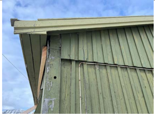
Innkledd gesims og tidstypiske paneldetaljer, lektepanel og markert overgang mot gavltrekant.
