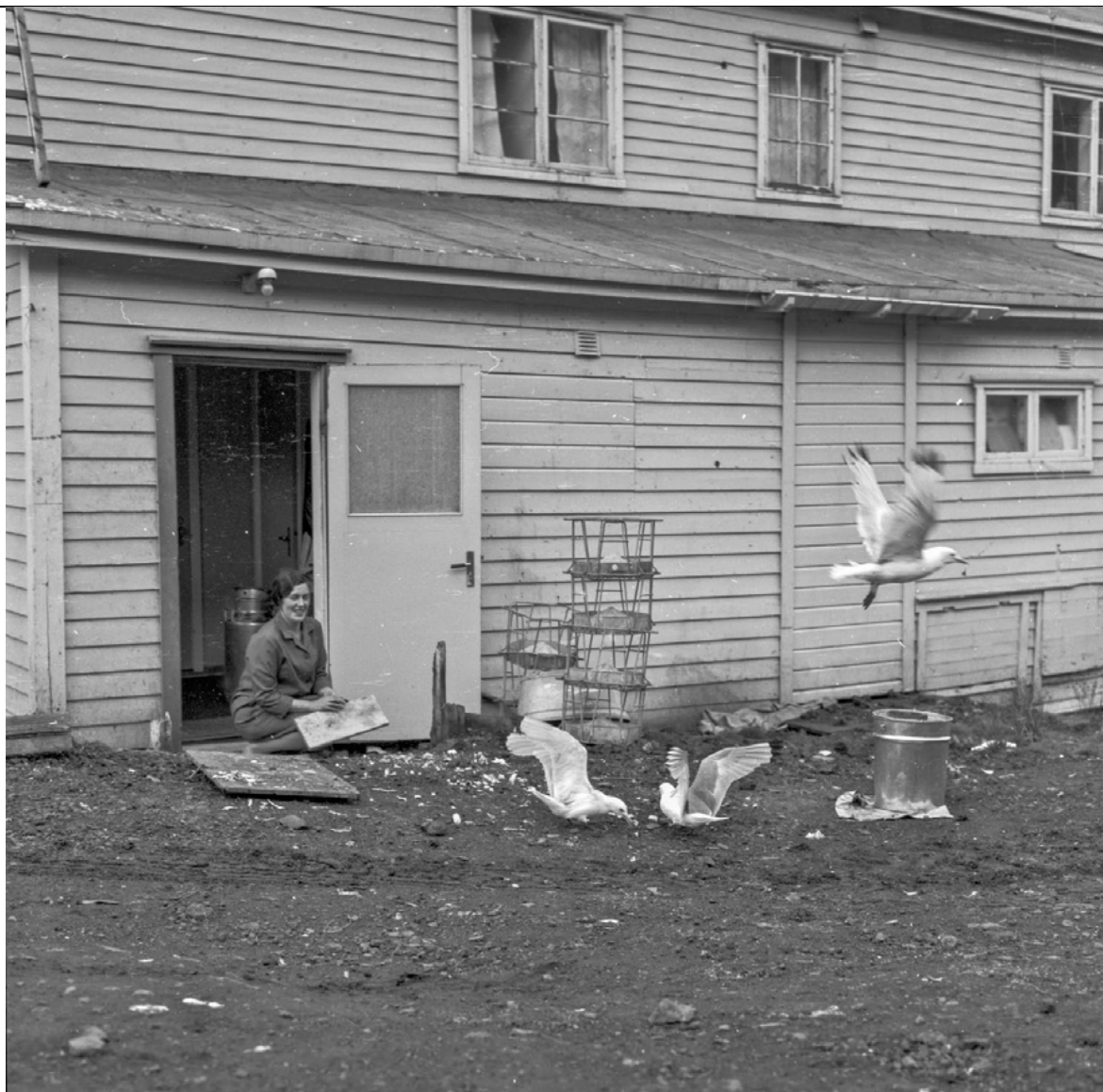
Opprinnelig utbygg mot sørøst, oppført samtidig med hovedbygningen i 1947 og revet midt på 1970-tallet. Foto: Herta Grøndal Lampert © Grøndal Foto
