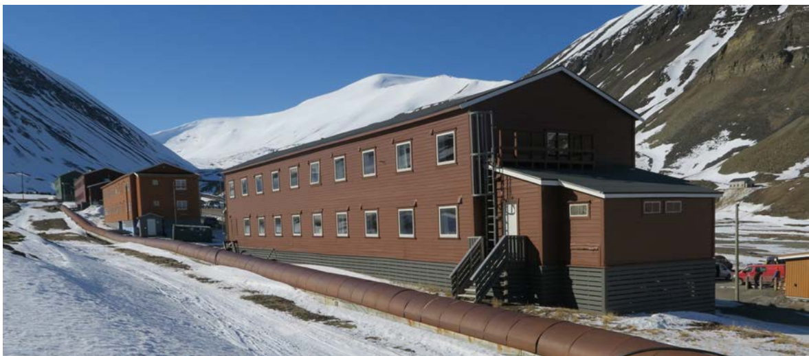
Sett fra nordøst. Opprinnelig utbygg med pulttak mot nord, dette fikk etter svært kort tid et ekstra tilbygg.
