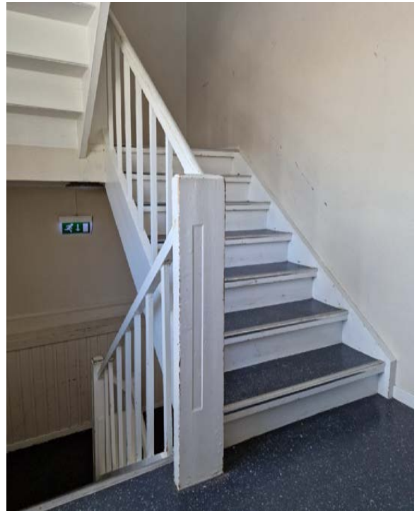
Hovedtrapp, nivå 1. etasje. Fint utført rekkverk av malt heltre, med enkel rektangulær profilering på meglere.
