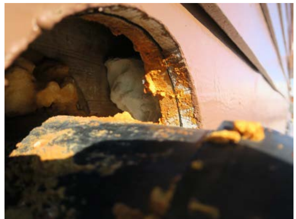
innblåst skumplast fra 1961 – hvit masse i mellomrommet. Foto der rør går inn i bygget. To lag opprinnelig kledning utenfor bindingsverket.
