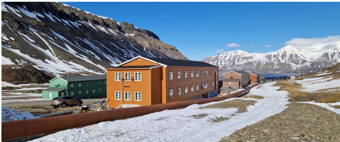
Vei 100-2 brasse 102 sett fra sørøst. Opprinnelig utbygg i kortvegg mot sør ble påbygget i 1974.
