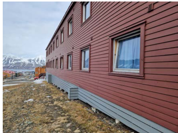
Langvegg mot vest. To nye fundamenter kommer ut fra vegglin og er kasset inn som en del av skjørtet. Kledningen er lektet ut og vindussmygene er blitt noe dypere.
