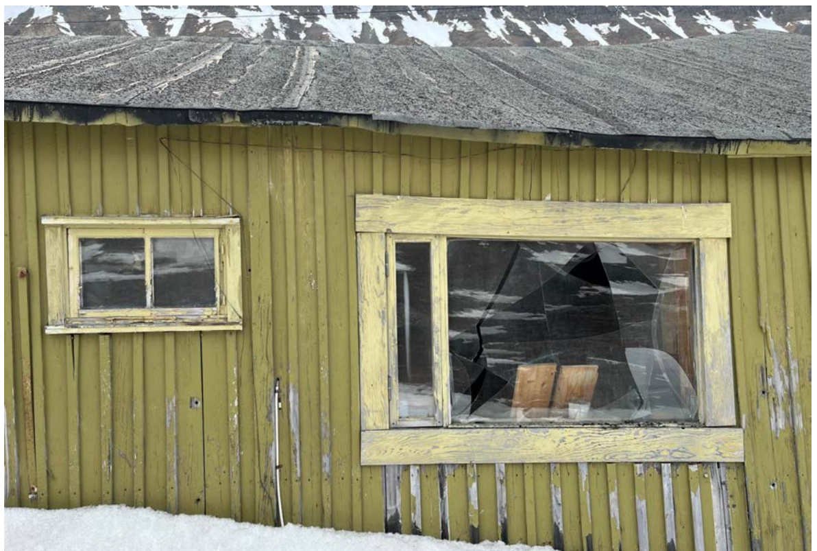
En opprinnelig og en utvidet vindusåpning mot øst. Hengsler står i sidekarmen i opprinnelig vindu.
