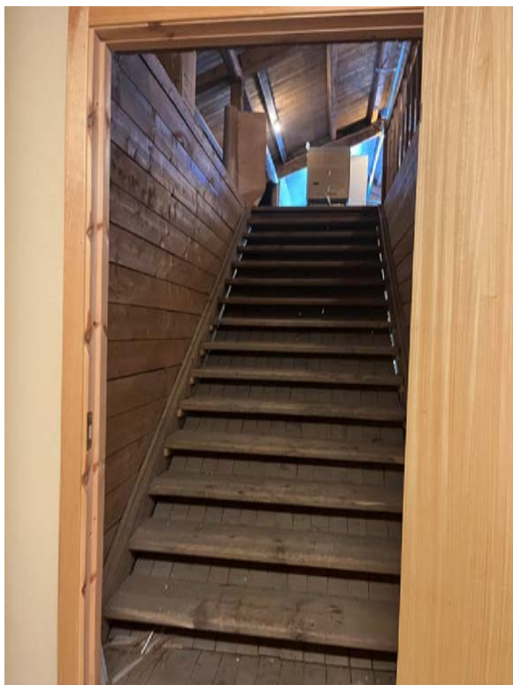
Loftstrappa er bevart med opprinnelig utførelse.
