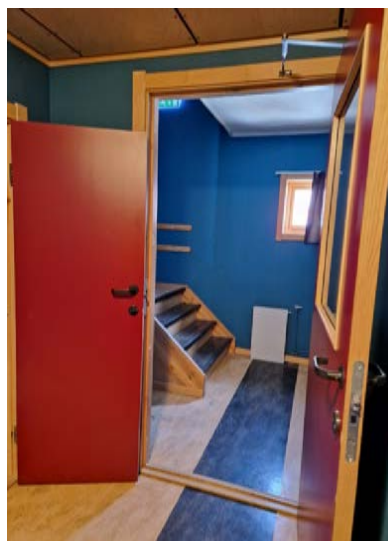
Trapp opp til 2. etasje. Antatt fra 1970, senere modernisert.
