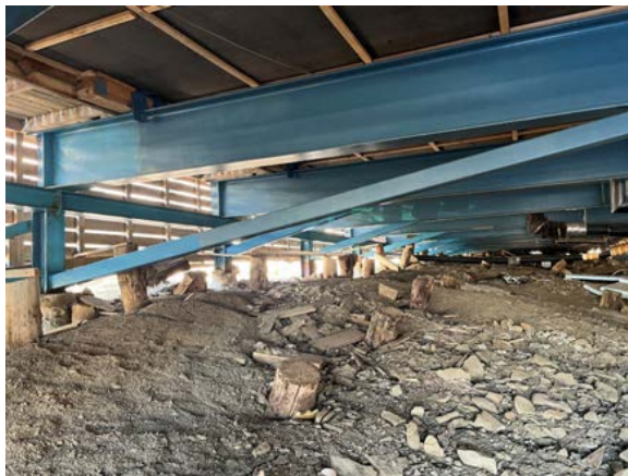
Ny type fundamentering med stålpeler, dragere og skråstag fra 1998. De gamle trepelene er kappet, tre rader under bygningen øst for opprinnelig støpt kjeller.
