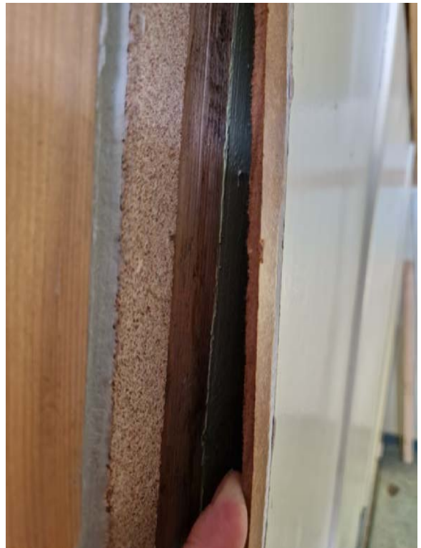
Detalj ved dør inn til korridor i brakke. Ser inn på stående grønnmalt panel, antatt opprinnelig fra 1947, bak huntonittplate.
