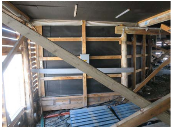
Ser mot nord. Innebygd rom i forkant av rom på bakkeplan i tilbygg.
