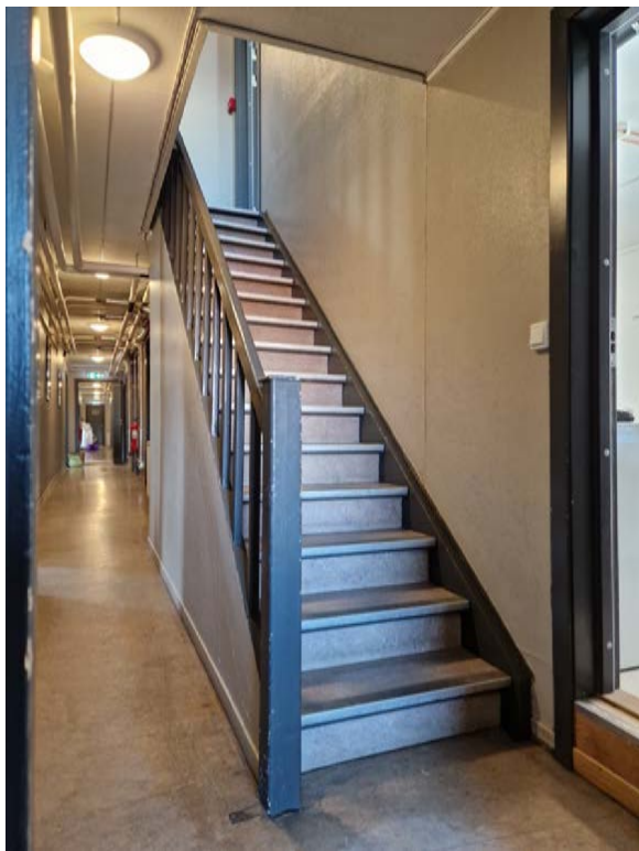
Trapp fra 1. til 2. etasje. Trappa er plassert som opprinnelig. Antatt opprinnelig trapp og rekkverk, med fornyete overflater.
