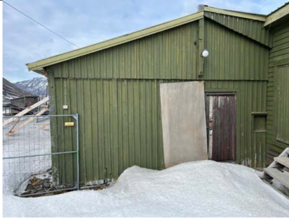
Opprinnelig tofløyet dør i kortveggen mot sør, med sikringsplate foran. Karakteristisk sprang i kledningen i gavltrekanten, slik vi også finner på svenskebrakker fra 1945 i Ny-Ålesund.
