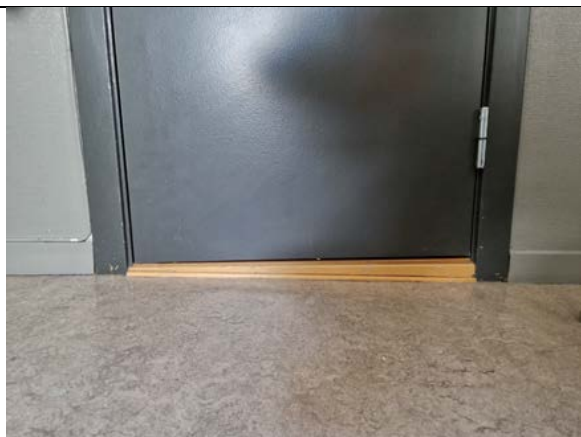
Dør ved trapp i 2. etasje. Tidligere avretting av setninger under dør. Materialene er fornyet i nyere tid.
