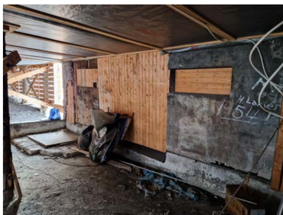
Rest av opprinnelig fyrrom, vegg mot vest. Betong ringmur ca. 40 cm opp fra terreng og deretter stående panel kledd med Rabitz-puss.
