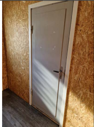
Tilbygg mot sør, eldre dør inn til del mot vest.
