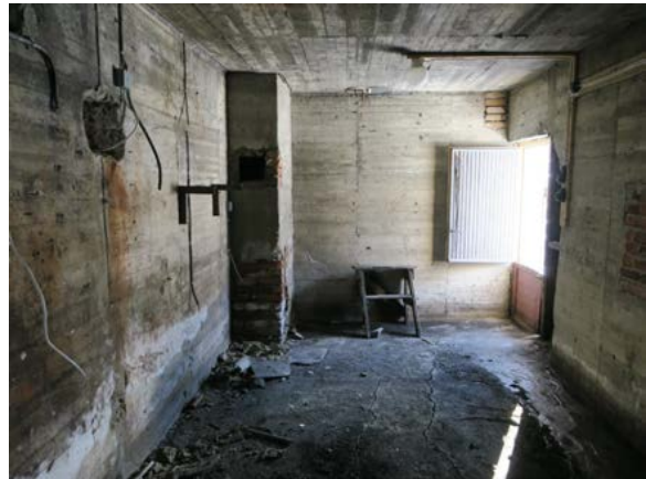
Tidligere fyrrom, sett mot sør. I hjørnet til venstre ses pipe og til høyre dør ut mot vest.
