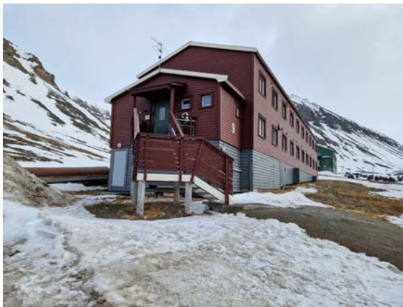
Ombygget tilbygg mot nord med nyere saltak og utvendig trapp.
