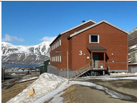
Tilbygget med hovedtrapp mot sør fra 1970–74 har skjevt røstet saltak. Senere utvidet mot vest med teknisk rom. Opprinnelig loftsvindu er blendet og skjuler seg bak nytt saltak på tilbygget.
