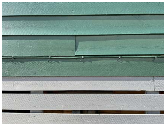
Kledning og skjørt har nyere bord, med spor etter sirkelsag.
