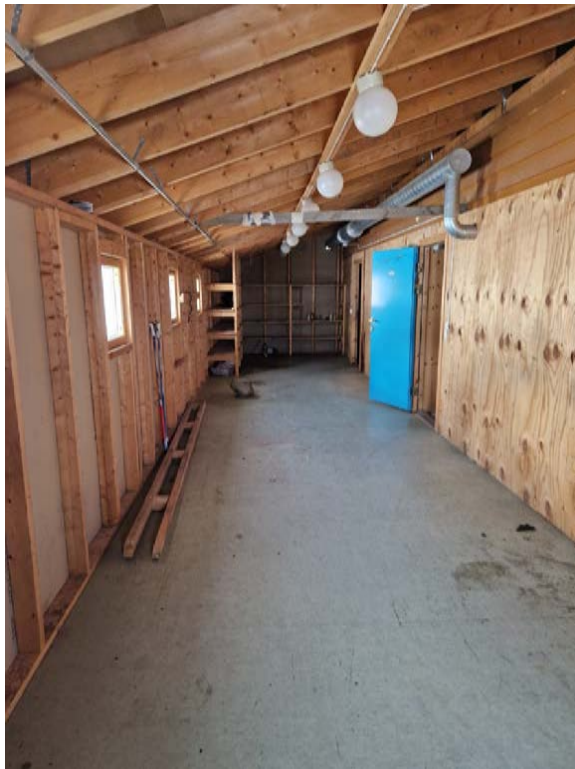
Uisolert nyere tilbygg ved nordøstre hjørne av hovedbygget.
