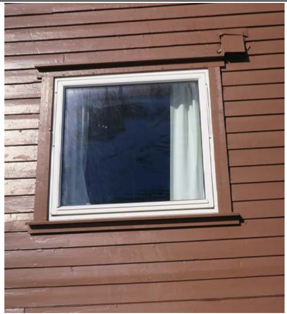
Nye vindustyper, men listverket rundt er inspirert av opprinnelig utførelse. Gammel ventil. Opprinnelig falsset supanel er bevart.
