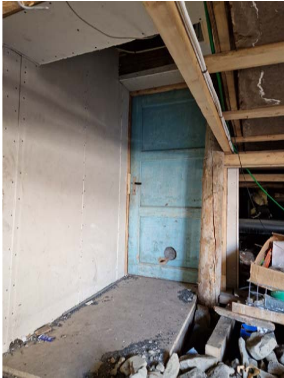
Eldre ramtredør inn til nytt teknisk rom på bakkeplan i tilbygg mot nord.
