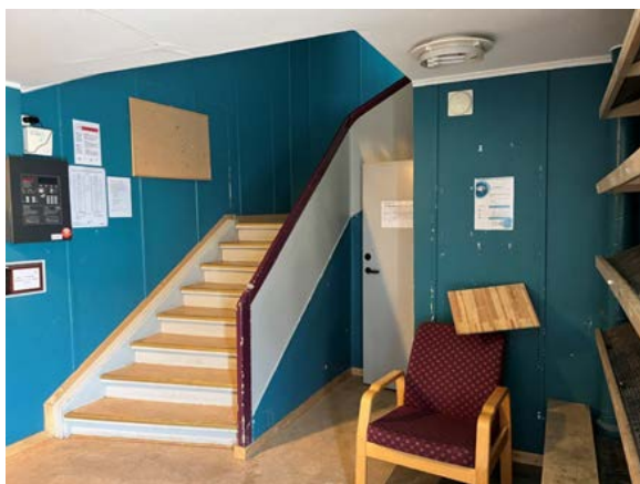
Hovedtrapperom i tilbygg mot sør fra 1970–74. Det er uklart om den opprinnelige trappa fra 1947 er flyttet og gjenbrukt, eller om trappa ble bygget ny.
