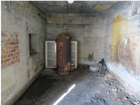
Opprinnelig fyrrom, sett mot nord. Tre gamle vinduer med karm er lagret.
