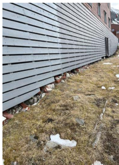
Nyere skjørt. Svill i bakken mot vest, eldre anlegg for rørgate.
