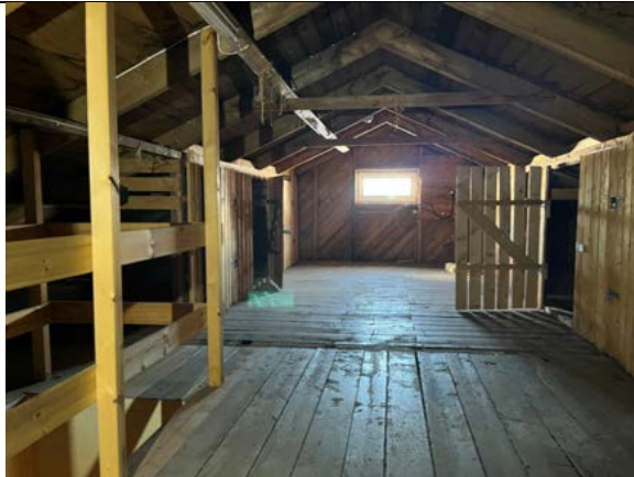
Opprinnelig råloft med synlige tak- og veggkonstruksjoner. Dels nyere bodinnredning.
