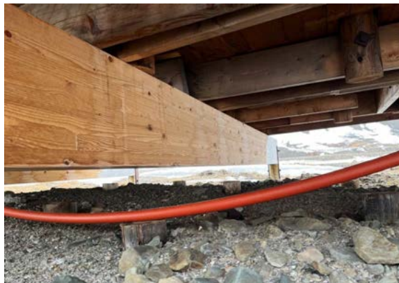
En av tre nye limtretrager som er spent opp under huset. De gamle pelene er kappet (oppe til høyre).
