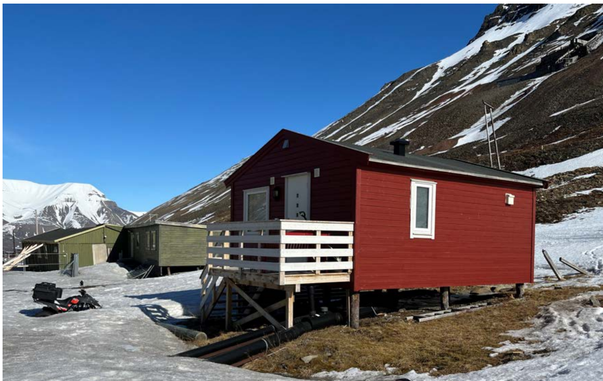
Fasader mot vest (med trapp) og sør. Bygningen ligger i skrånende terreng med noe avstand til veien. De eldre bygningene Snekkerverkstedet og Maleverkstedet ses i bakgrunnen, samt Gruve 2B i fjellsida.
