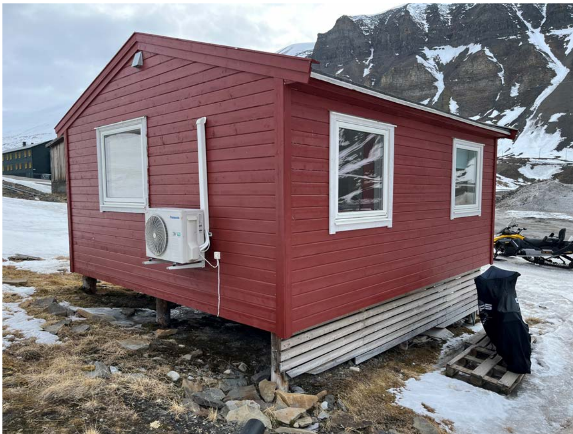
Fasader mot øst og nord. Tradisjonelle fundamenter med trepeler og utvendig skjørt.
