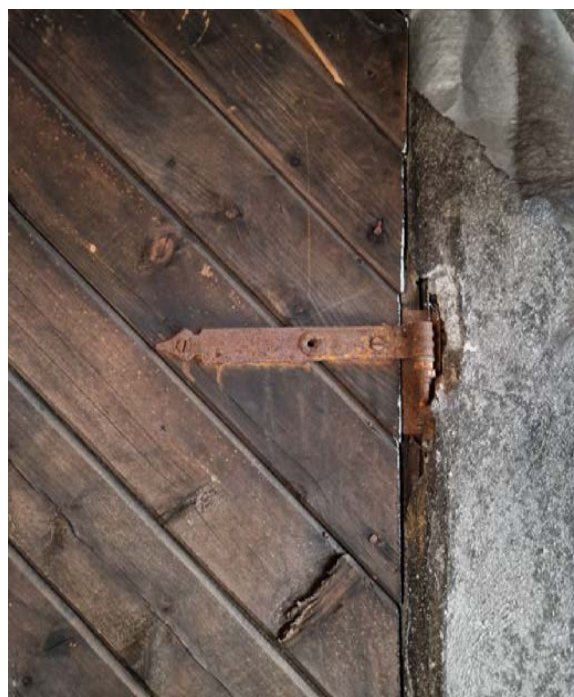
Stabelhengsel på dør, ref. bildet til venstre.
