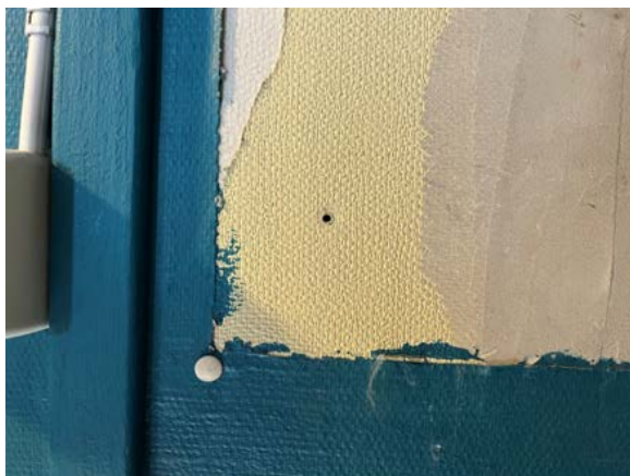
Veggen i trapperommet har plastbelagt gips (Gipsonyl), som i brakke 102 anno 1974.
