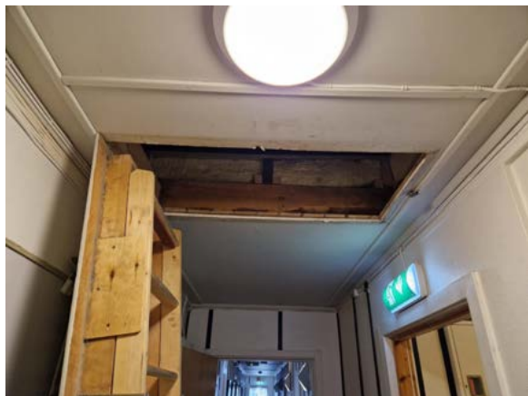
Eldre loftsluke i 2. etasje, med stige til råloftet.
