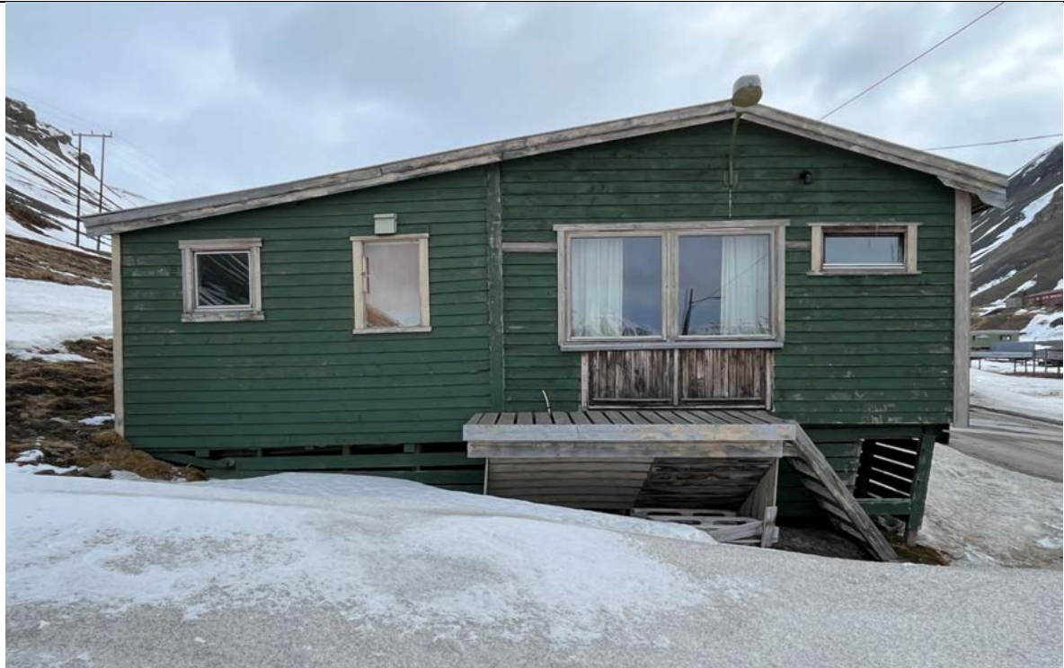
Fasade nord. Trapp opp til opprinnelige tofløyet inngangsdør mot nord, der det senere er satt inn et bredere tofags vindu i del av dørfeltet. Tilbygget har liggende supanel, i likhet med brakkene i Nybyen.
