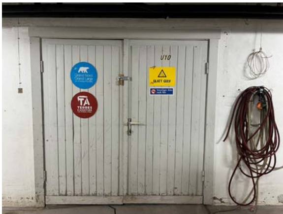
Flere gamle dører er bevart i kjellerens lagerdel.
