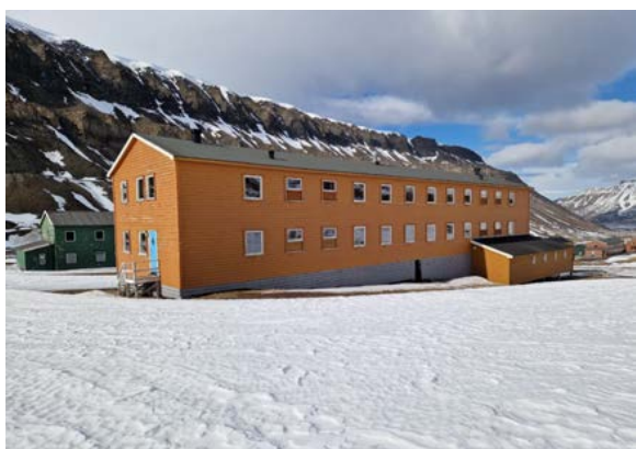
Gavl mot sør og langvegg mot øst.
