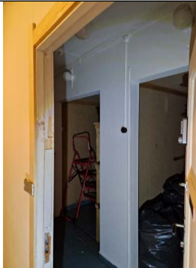
Utbygg mot nord. Ser inn på del av tilbygget lengst mot nord, som har luke for tømning av opprinnelig bøttedo.
