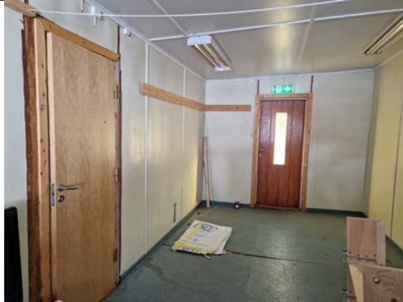
Opprinnelig utbygg mot sør, her sett mot øst. Rommet er kledd med huntonittplater på vegger og himling. Plateskjøter er dekket med trelister.
