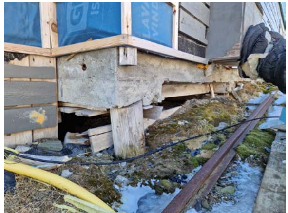
Detalj hjørne av betong (opprinnelig fyrrom), som hviler på pelefundament av tre, ref. bildet til venstre.
