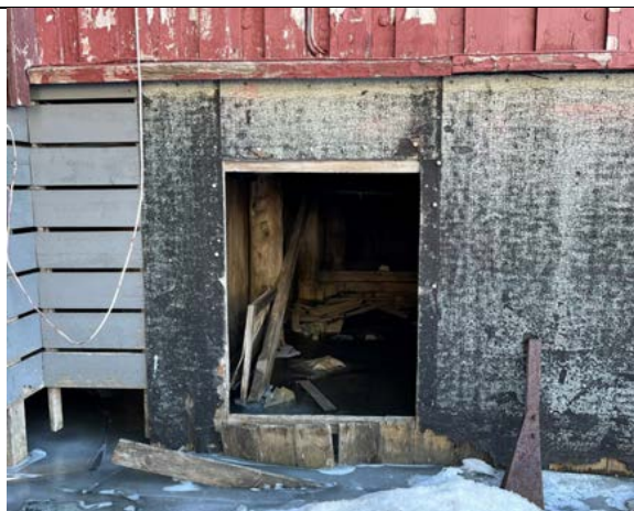
Det er bevart eldre skjørt av stående bord og utvendig papp. Dette tilsvarer opprinnelig løsning. Her inngangsluke mot vest.
