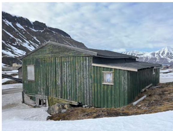
Bygningen fra sørøst, opprinnelig hovedbygning og langt tilbygg med pulttak mot øst.
