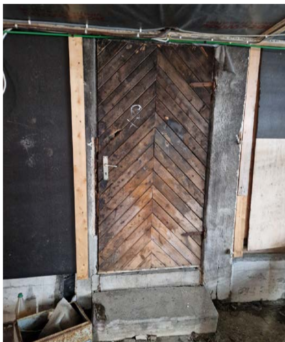
Dør inn til rom på bakkeplan for utbygg nord. Eldre dør med panelt fiskebeinsmønster.
