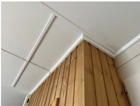
Himling med lister og skyggepanel har eldre karakter, antatt bevart fra ombyggingen i 1970–74.
