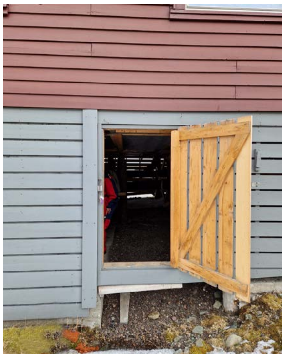
Inngang under bygningen til pelefundament, port i skjørt på langvegg vest.
