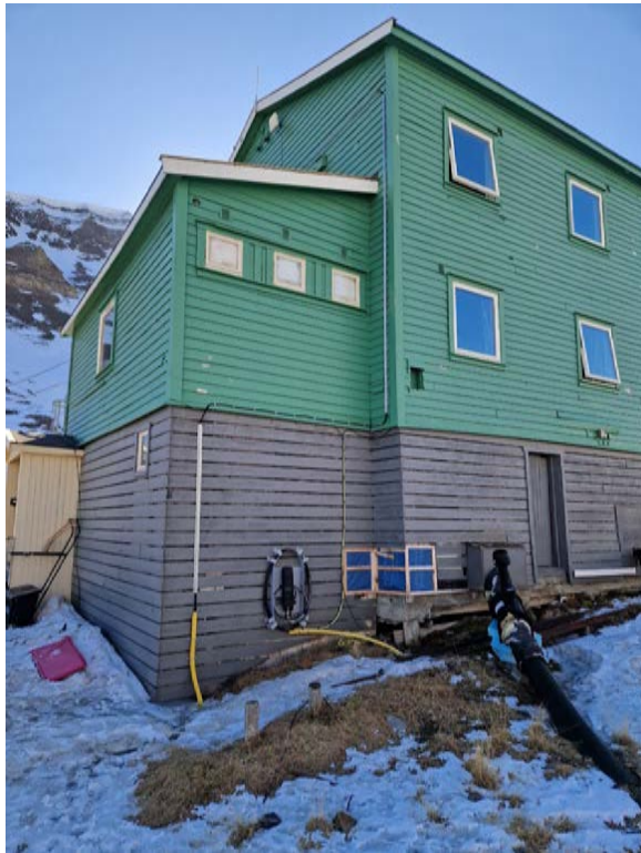
Opprinnelig utbygg mot nord. Karakteristisk eldre vindusbånd er bevart, dette går igjen på flere utbygg i andre arbeiderbrakker i Nybyen.
