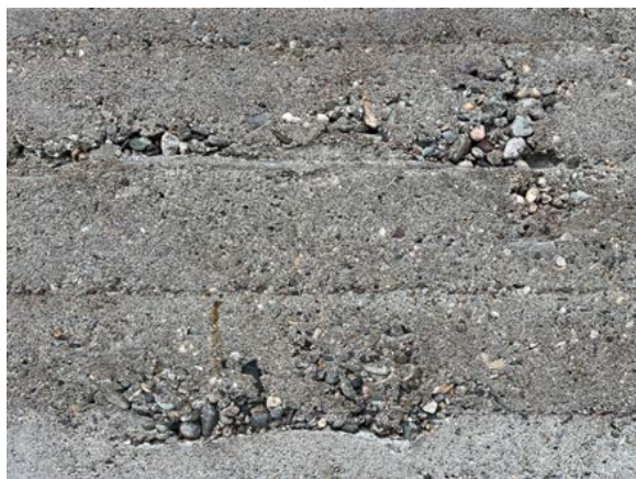
Plasstøpt betong, antatt tilslag av lokal grus.
