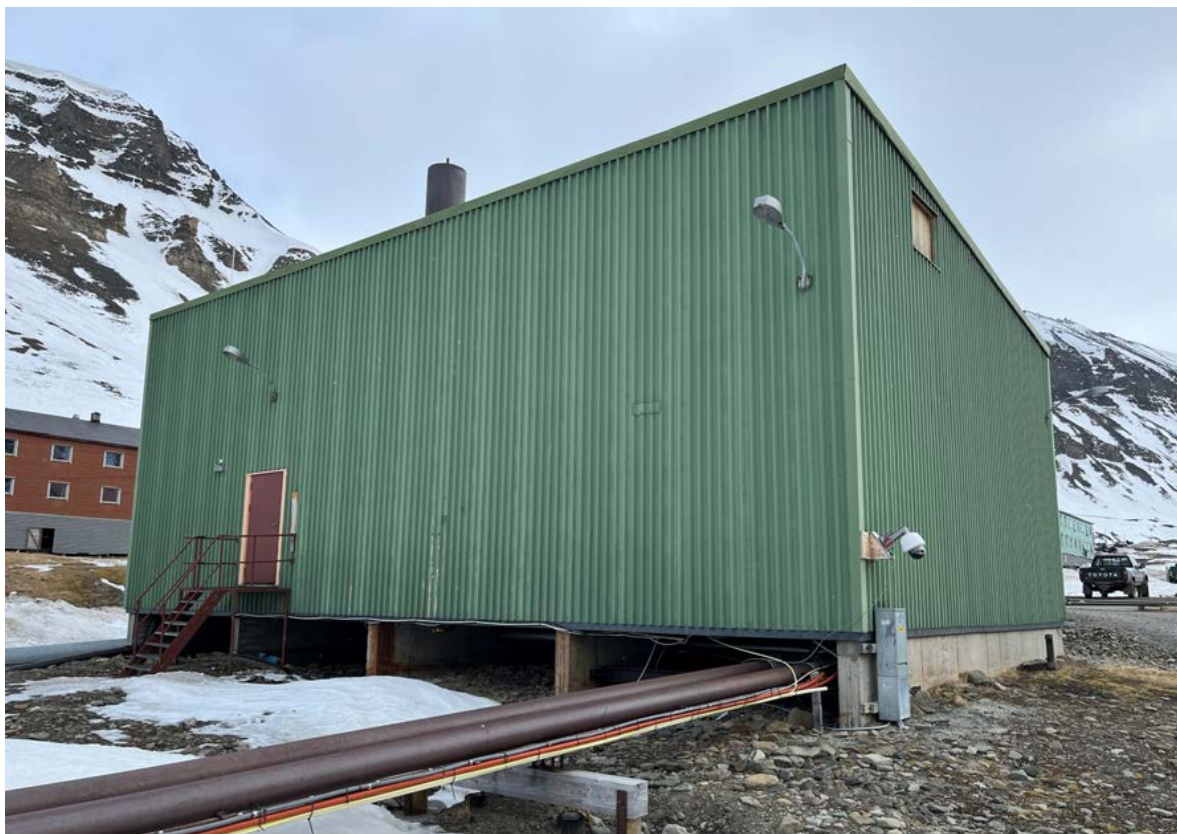
Fasade nord med rørgate, fasade vest mot elveleiet. Fem støpte betongskiver utgjør fundamentet.
