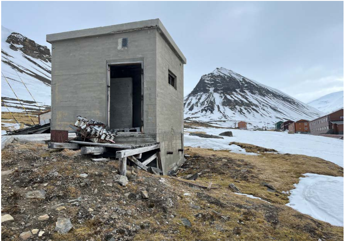
Transformatorkiosken sett fra nord med Nybyen i bakgrunnen. Fasade nord med døråpning, fasade vest med smalt vindu, der sprosser og glass mangler. Fasadeutformingen er for øvrig som opprinnelig.
