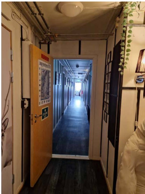
Korridor 1. etasje mot nord. Kledningsmaterialer med lister fra 1974 er bevart på vegger og himling.
