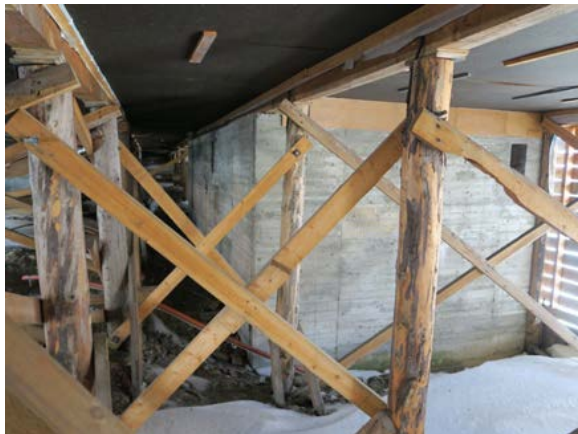
Ser mot støpte betongvegger til fyrrom. Flere peler har smale klosser/bordbiter oppunder bjelkene.
