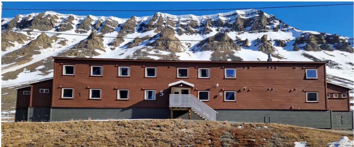
Fasade vest. Det er bevart gamle ventiler til rommene i langfasadene. Blendete vinduer mot nye bad.
