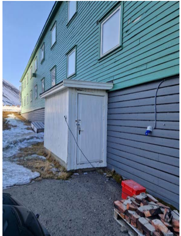
Lite tilbygg på langvegg mot øst, oppført tidlig på 1960-tallet. Stående skyggepanel på vegg, og eldre dør med smalt skyggepanel.
