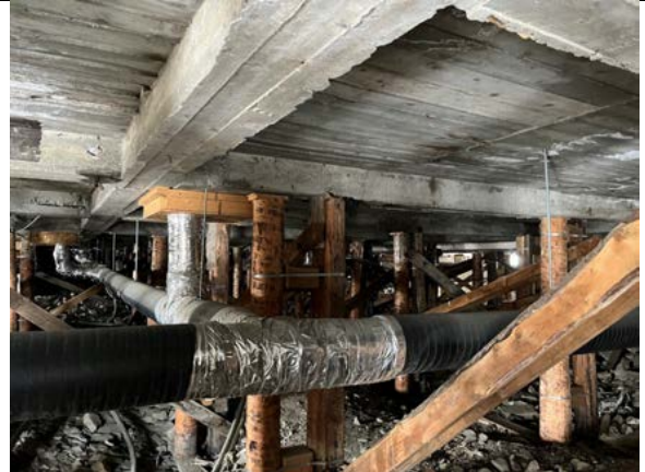
Betongdekket under kjelleretasjen har plasstøpte dragere i to retninger, pelefundamentene står under disse.
