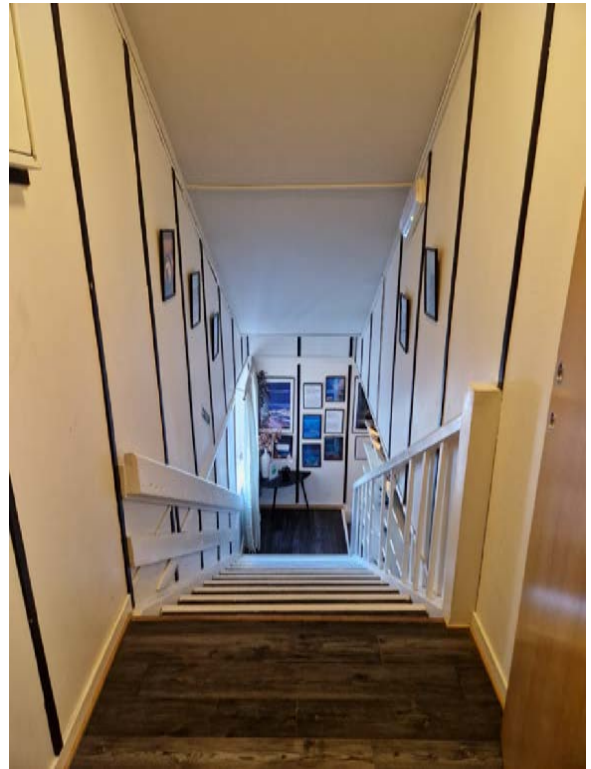
Trapp mellom 1. og 2. etasje fra 1974. Tidstypisk veggbekledning med plater og lister.
