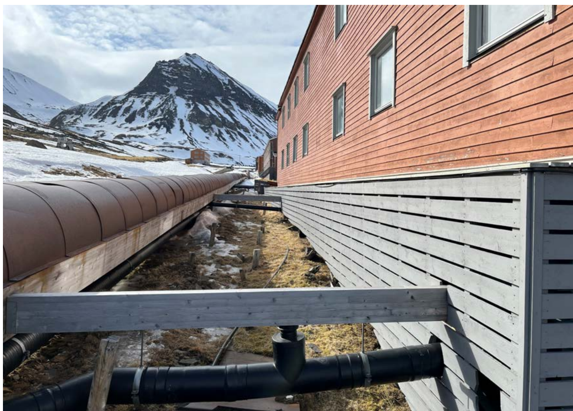
Ny rørgatekonstruksjon øst for bebyggelsen, her langs bygning nr. 107 Jomfruburet.
