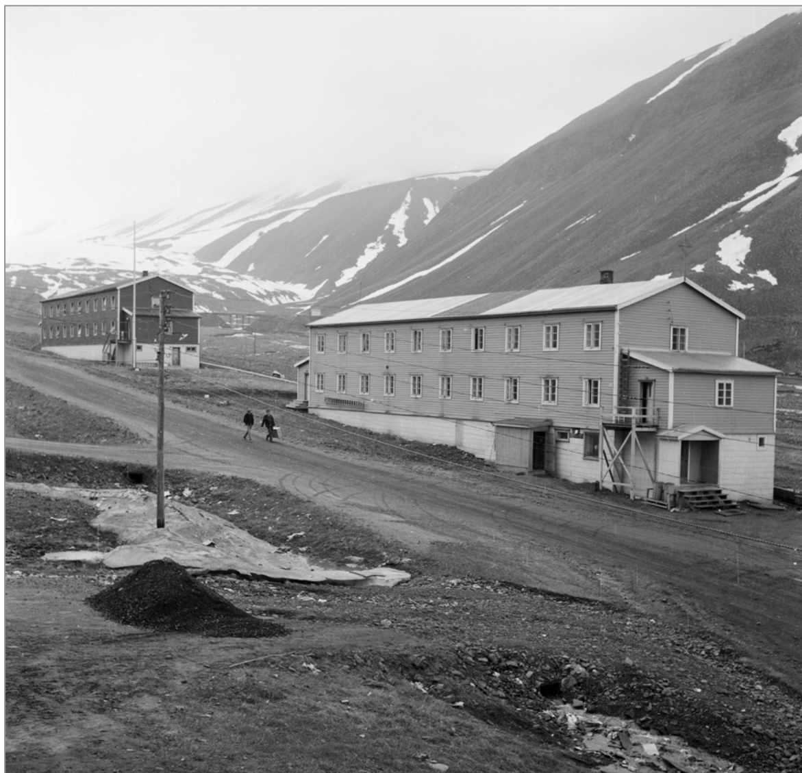
Brakke 104 i forgrunnen på 1960-tallet. Inngangspartiet mot nord er nylig bygget om: Utvendig trapp til 1. etasje er fjernet, reposet står fortsatt igjen som en slags veranda. Nytt bislag med saltak er oppført mot nord, der det ble etablert ny innendørs hovedtrapp opp til 1. etasje. Det lille tilbygget mot øst er også oppført. Dette er svært lik dagens situasjon. Foto: Herta Grøndal Lampert © Grøndal Foto
