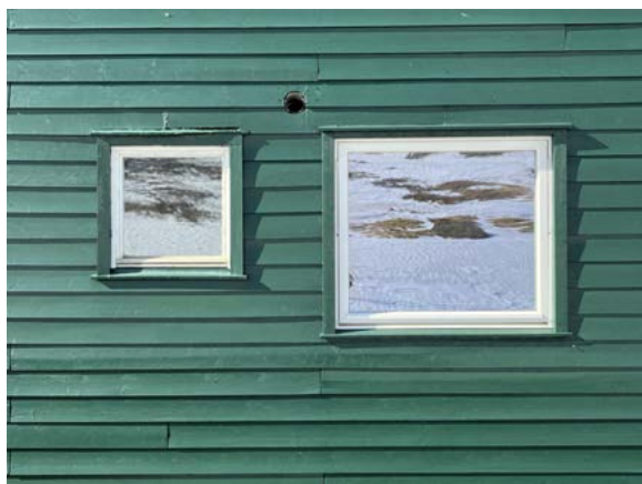
Typiske nyere isolerglassvinduer fasade øst.
