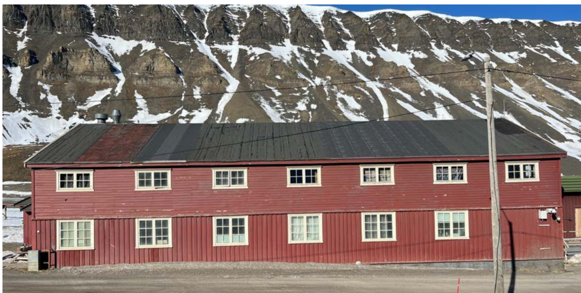
Fasade øst. Flere vinduer i 1. etasje er utvidet i høyden. Midtstilt lasterampe med dør er fjernet.
