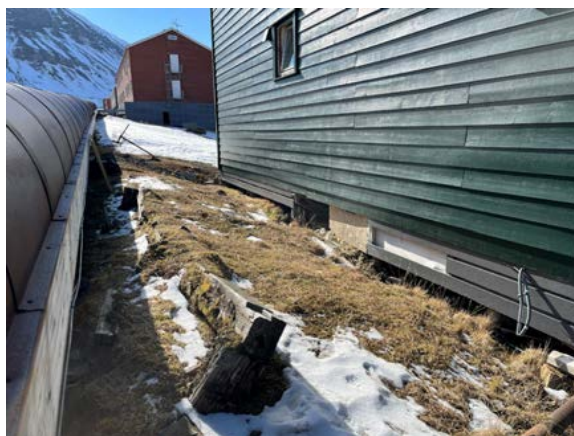
Ved østveggens søndre del ses fundamentene etter opprinnelig énetasjes utbygg, revet ca. 1974.
