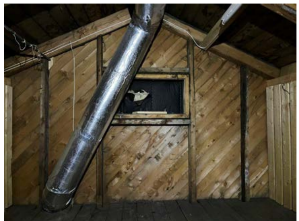
Gavlvegg mot sør med enkelt bindingsverk og utvendig skråstilt kledning. Blendet opprinnelig gavlvinde. Tilbygget mot sør har et skråtak som krysser midt utenfor vinduet.
