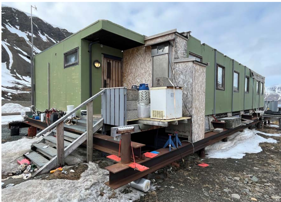
Drosjeriggen sett fra sørøst, med inngang på hjørnet. Kjøreatkomsten er fra en nyere vei i vest.
