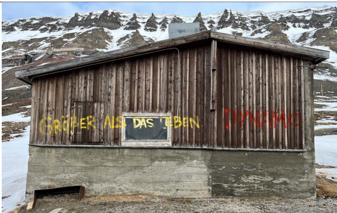
Fasade vest mot veien. Skillet i to byggetrinn ses som en vertikal skjøt i støpt grunnmur. Vinduet vender inn mot pauserommet, der det er bevart innredning og enkel møblering (kun sett gjennom vinduet).
