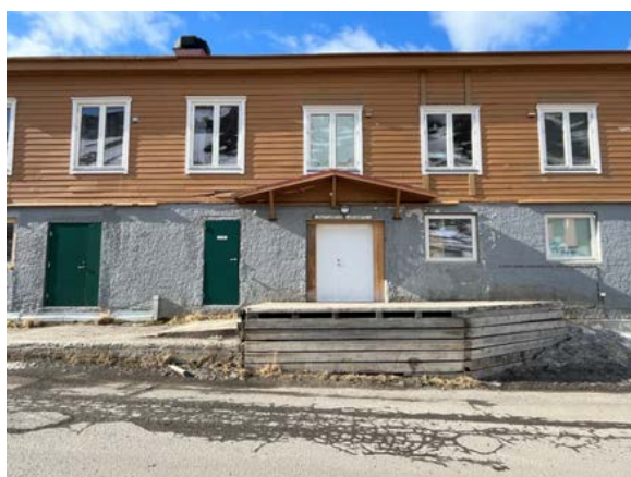
Utsnitt fasade øst mot veien. Lasterampe av betong/tre og lite letak er eldre elementer fra tida som messe for Store Norske. De lavere vinduene er endret, spor ses i kledningen.
