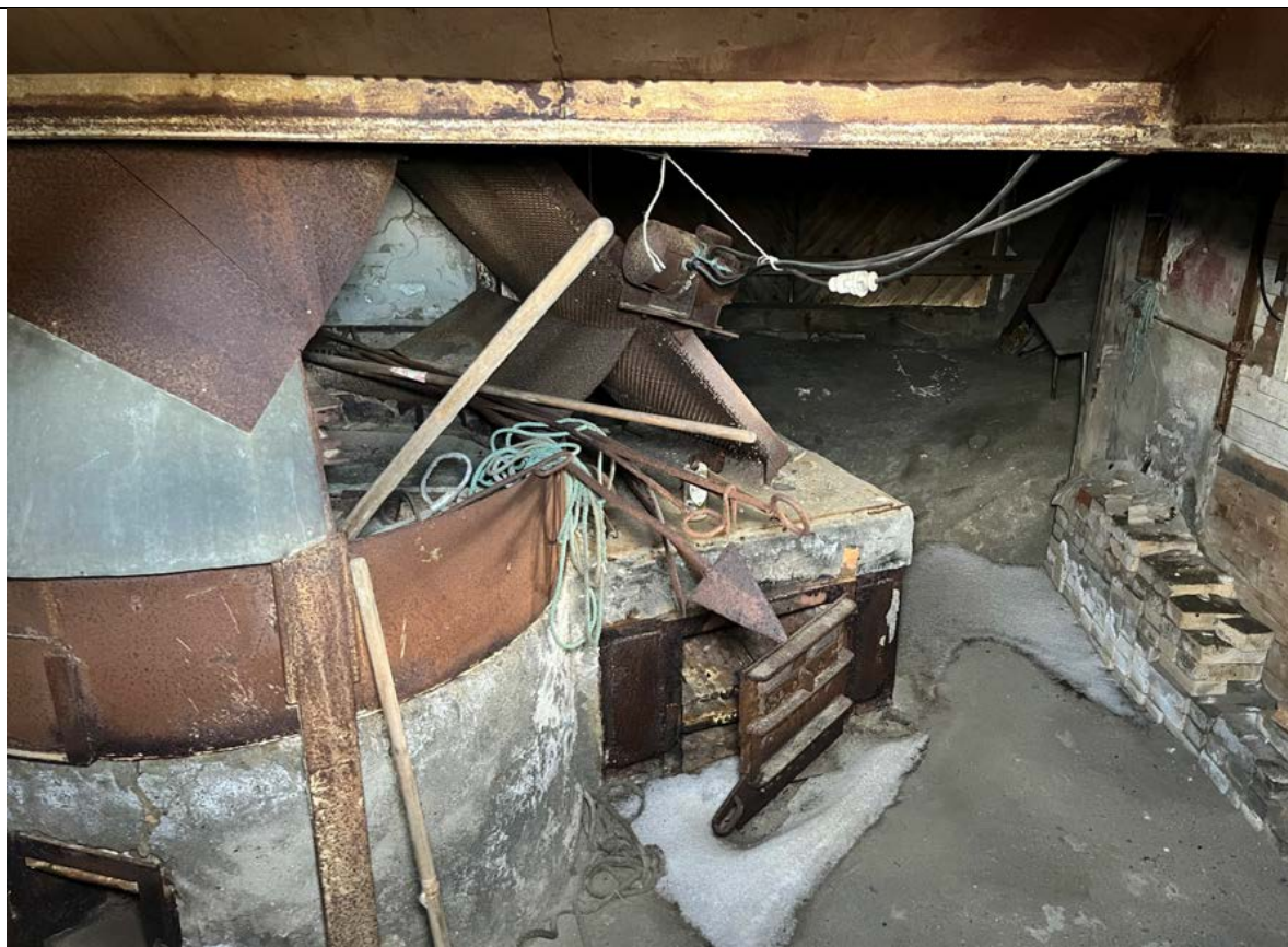
Interiør med sandtørke/ovn, sett gjennom glugge i nordveggen.
