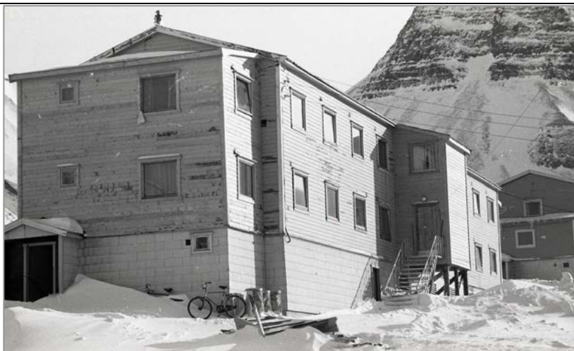
Brakke 102 i 1975, året etter ombygging med nye tilbygg og utskifting til ettrams husmorvinduer. Skjørtet foran pelefundamentene var kledd med eternittplater. Foto: Herleiv Alvheim, Svalbardposten / Svalbard museum SVF 44692
