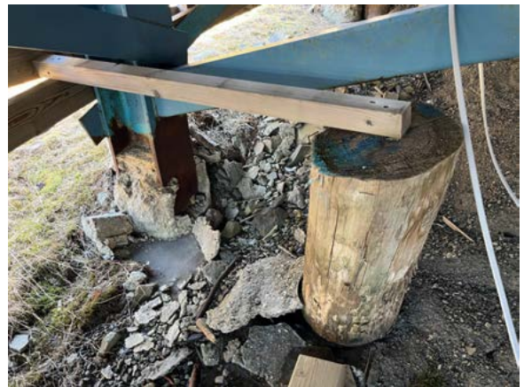
De nye stålpelene er boret ned i bakken et stykke utenfor yttervegg og opprinnelige peler.
