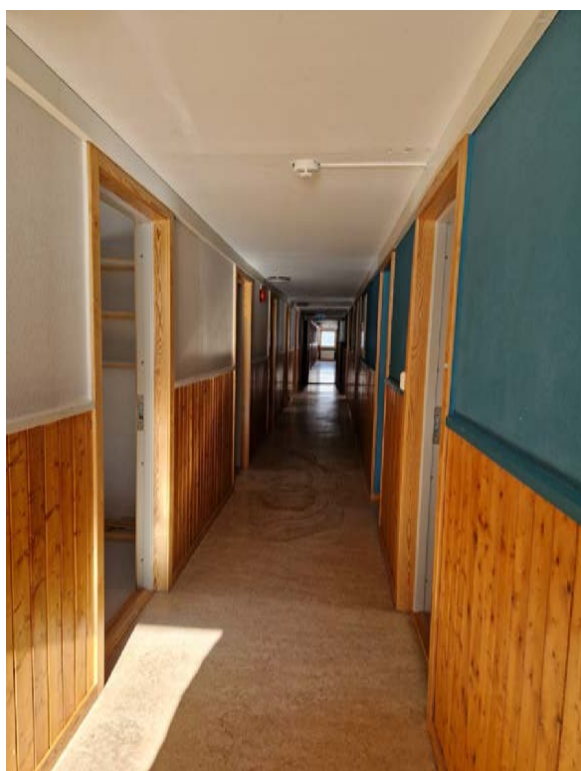
Korridor 1. etasje. Eldre brystningspanel.
