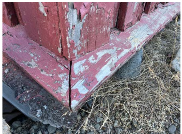
Enkle vannbrett av skråstilt plank, gjæret hjørne. Datering usikker, muligens opprinnelig løsning. Ingen profiler.
