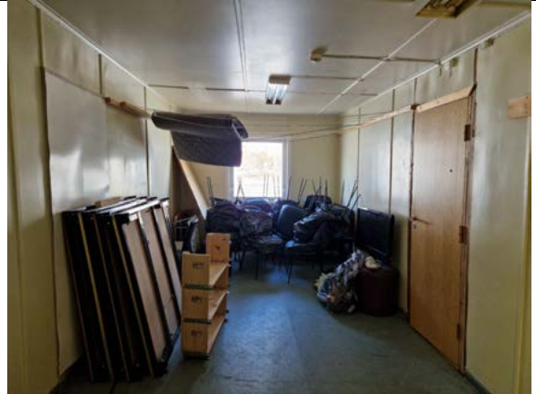
Utbygg mot sør, sett mot vest. Dør mot sør, som er synlig på utsiden, er skjult bak tynn plate til venstre i bildet.
