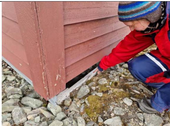
Opprinnelig utbygg mot sør. Det er bevart rester av eldre stående panel for skjørt.
