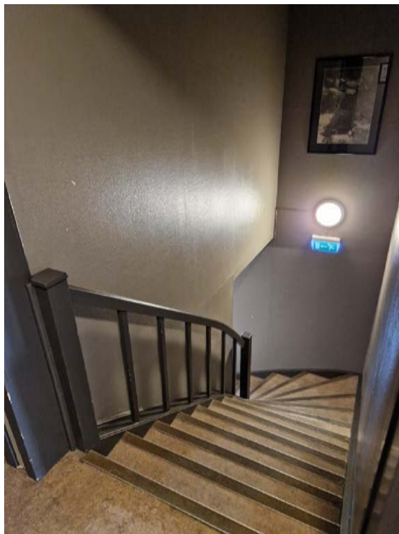
Ser ned trapp fra 2. etasje. Trapp trolig fra begynnelsen av 1960-tallet samtidig med nytt inngangsparti på langveggen mot vest.
