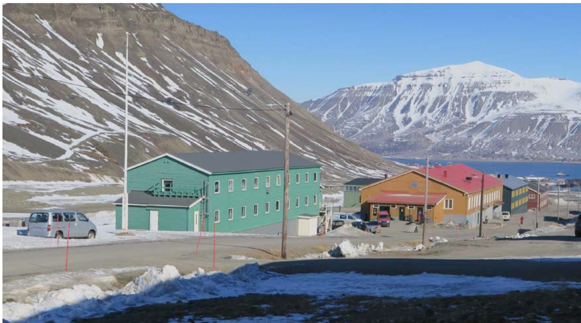
Vei 100-8 brasse 104 sett fra sørøst, med Stormessa som nærmeste nabo i nord.
