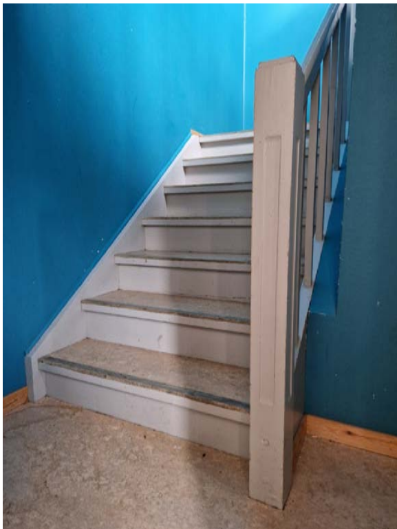
Bitrapp i sørenden av bygget. Trapp og rekkverk har samme utforming som hovedtrappa, men med innfelte eikelekter som trappeneser.
