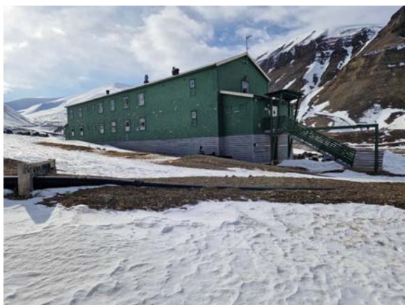
Langvegg mot øst og gavl med utbygg mot nord. Nyere trapp ved hovedinngang i nord.
