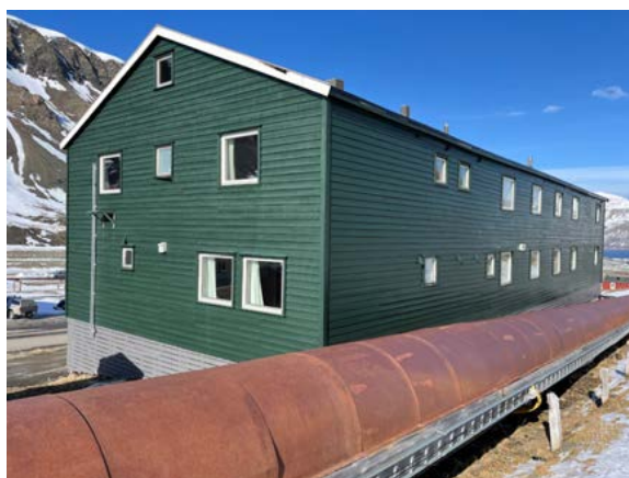
Kortvegg mot sør og fasade øst mot rørgata og fjellet. En del opprinnelige vindusåpninger er blendet, ny kledning går forbi.
