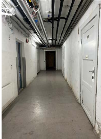
Opprinnelig korridor med støpte hovedkonstruksjoner i kjeller.
