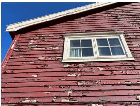
Vindskiene har buet nedre del, som opprinnelig. Denne detaljen ble brukt på flere hus i Nybyen, og avviker fra arkitekt Hanssens detaljtegning.
