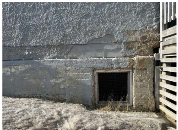
Spritpuss på støpt kjeller, spor etter liggende forskalingsbord i det støpte skjørtet. Her ses en lufteluke mot øst, inn mot pelefundamentene.
