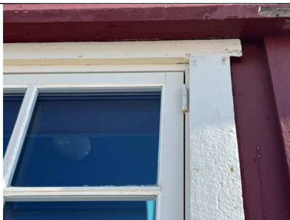
Mange vinduer har bevart opprinnelig listverk med små spor/hakk i toppen for uttak av sidehengslete rammer.
