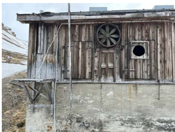
Utsnitt av nordveggen med luker og vifte.
