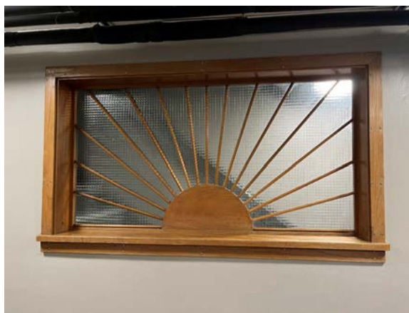
Forseggjort sol-vindu med tresprosser og trådglass mellom gang og innvendig trapp i 1. etasje.
