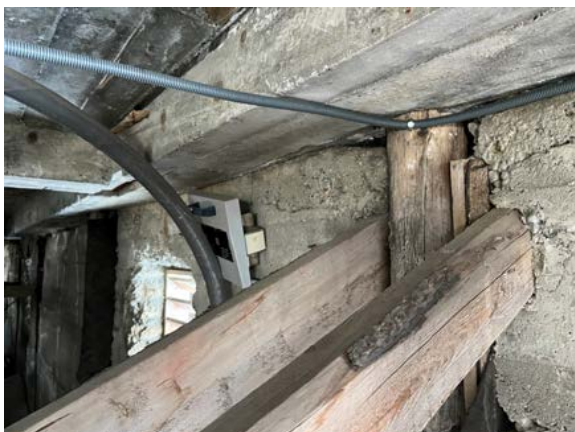
Detalj av opprinnelig innstøpt pele i støpt skjørt.
