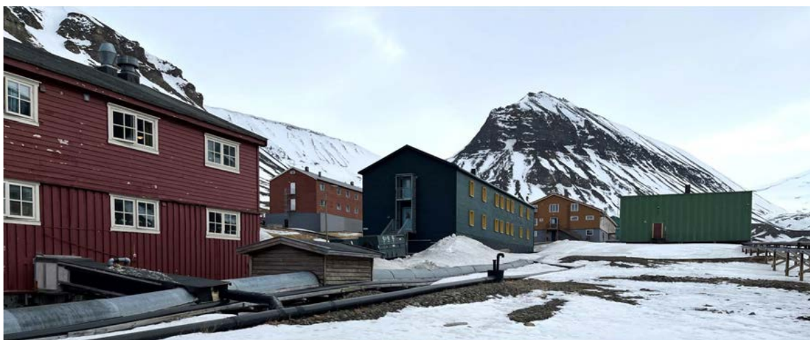
Hybelbygget midt i bildet, fra nordvest. Nybygget ligger på tomte til det opprinnelige Badet, mellom Butikken t.v. og Stormessa. Badet var ett av tre viktige felleshus i gruvebyen, disse tre lå på rekke her.
