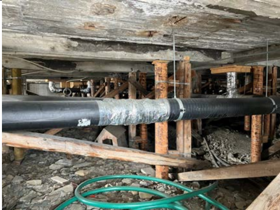
Pelefundamenter og nye rørføringer under støpt kjeller.
