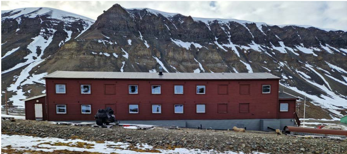
Vei 100-9 brakke 103, langvegg mot øst. Fasadestrukturen med ti vindusakser er som opprinnelig, men en del vinduer er blendet i begge etasjer ved innredning av bad/WC.
