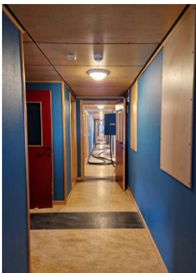
Korridor 1. etasje. Trapperom inn til venstre.
