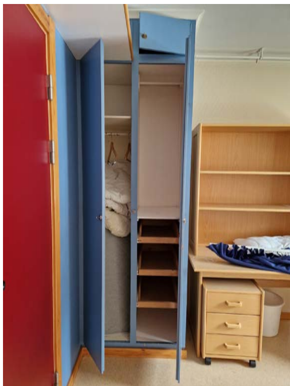
Eldre skap brakkerom fra 1970. Opprinnelig hylleinnredning og hengsler/vridere er bevart.
