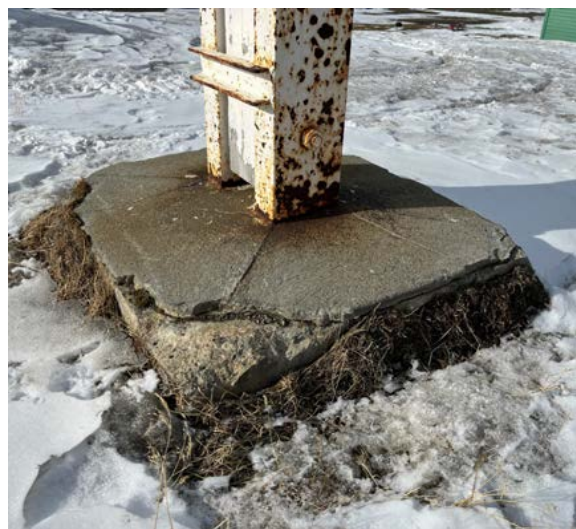
Plasstøpt fundament av betong, toppavdekning av finere sementstøp.
