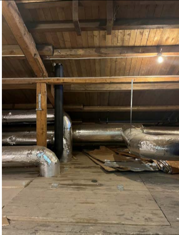
Lem i loftsgulv og heiseanordning over. Denne hadde forbindelse ned til 1. etasje og lasterampa.
