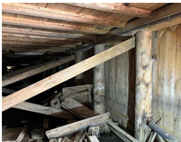
Opprinnelig pelefundament og skjørt mot vest. Se detalj av vegg på bildet t.h. Opprinnelig tett skjørt av stående bord er bevart.
