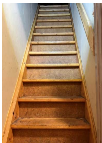
Loftstrappa er bevart med opprinnelig posisjon tilknyttet opprinnelig bitrapp (nå bad).
