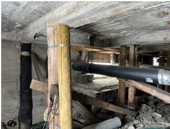
Mange peler er fornyet, nye peler er satt inntil de gamle og sammenbundet med metallbånd.
