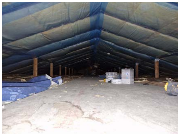
Inne på loft. Ny isolasjon mellom sperrene.
