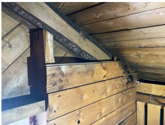
Gavlvegg mot nord, med skrå kledning utenpå bindingsverket. Innvendig liggende panel er ikke komplett
