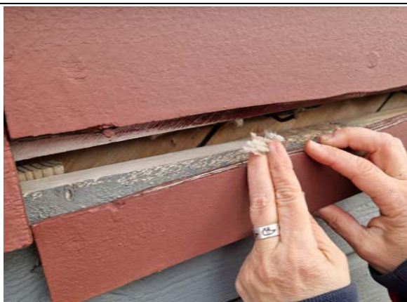
Nytt liggende supanel er lektet ut og etterisolert, trolig renovering 1977. Opprinnelig skråpanel bak.
