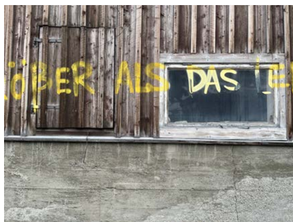
Fasade vest, t.v. opprinnelig luke med lektepanel, og topphengsløst vindu.
