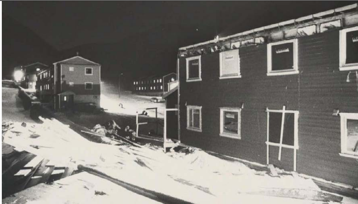
Brakke 101 under rehabilitering, muligens 1990-tallet. Avdekket bindingsverk med opprinnelig skråstilt underkledning i øvre del av vegg. Nye isolerglassvinduer settes inn. Foto: Svalbardposten, udatert (beskåret topp/bunn). Kilde: nb.no
