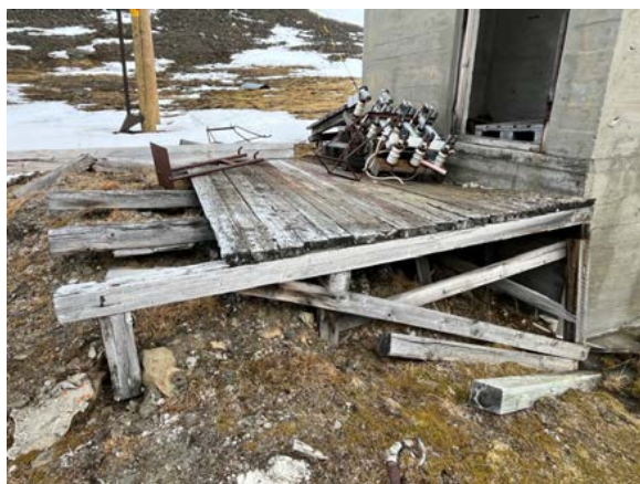
Trammen mot nord. Teknisk utstyr er henslengt ute på trammen, se foto av dette t.h.
