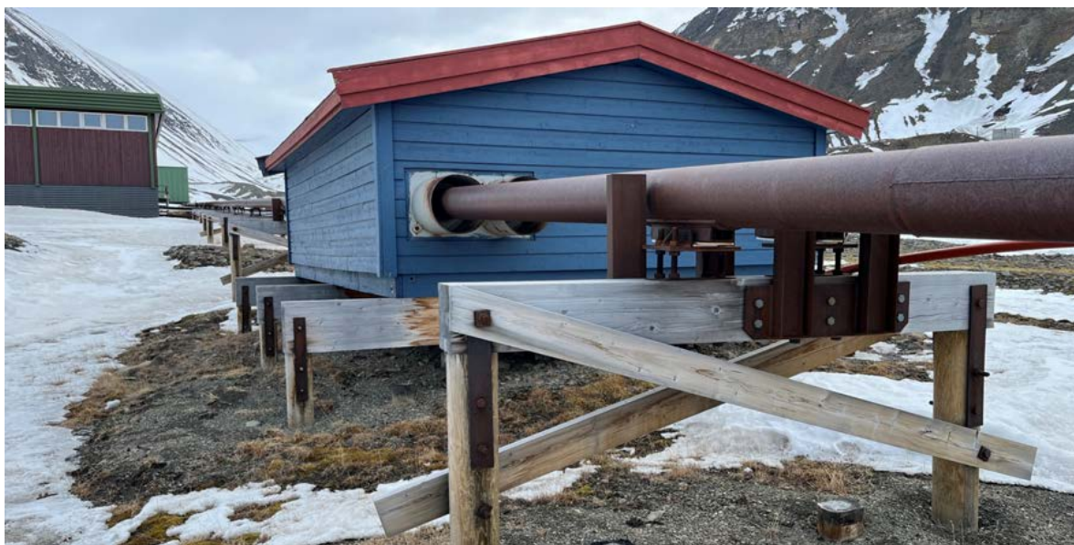
Fra nordøst. Det nye fyrhuset skimtes i bakgrunnen, der rørgata går inn. Eldre peler midt under rørgata.
