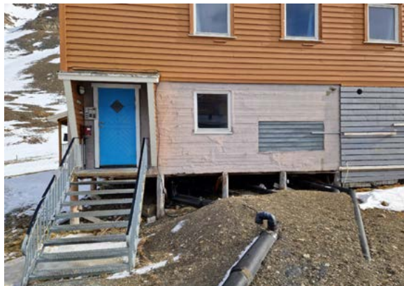
Hovedinngang mot vest. Støpte betongvegger hviler på peler. Tidligere fyrrom innenfor.
