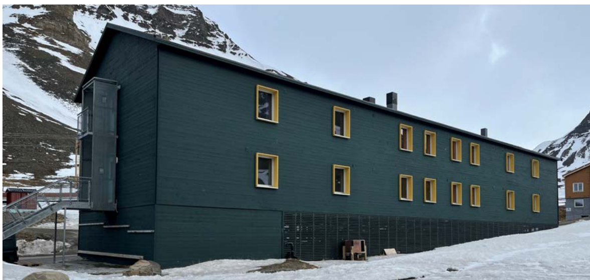
Fasade nord med rømningstrapp, fasade vest med enkle vinduer til rommene.
