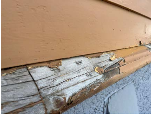
Opprinnelig vannbrett er bevart, med høllet profil (øvre hulkeil, liten vertikal, og avrundet nedre del). Tilsvarende vannbrett ble også brukt på arbeiderbrakkene.
