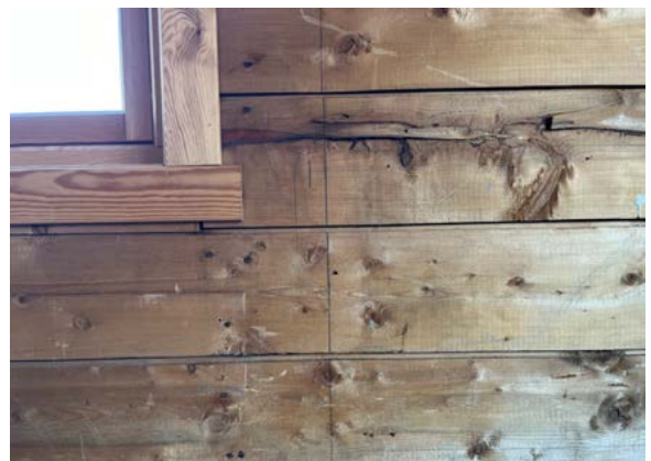
Opprinnelig panel med not/fjær 2. etasje nord.
