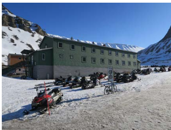
Langvegg mot vest og gavl med utbygg mot nord.
