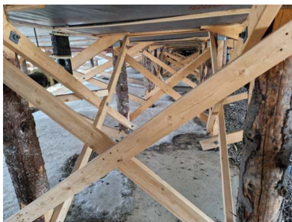
Nyere støpt plate i midt som peler er boltet fast i.
