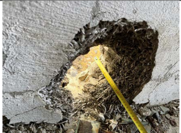
Innside vegg med 10 cm treullsement og tynn puss. Ca. 15 cm bærende betongvegg.
