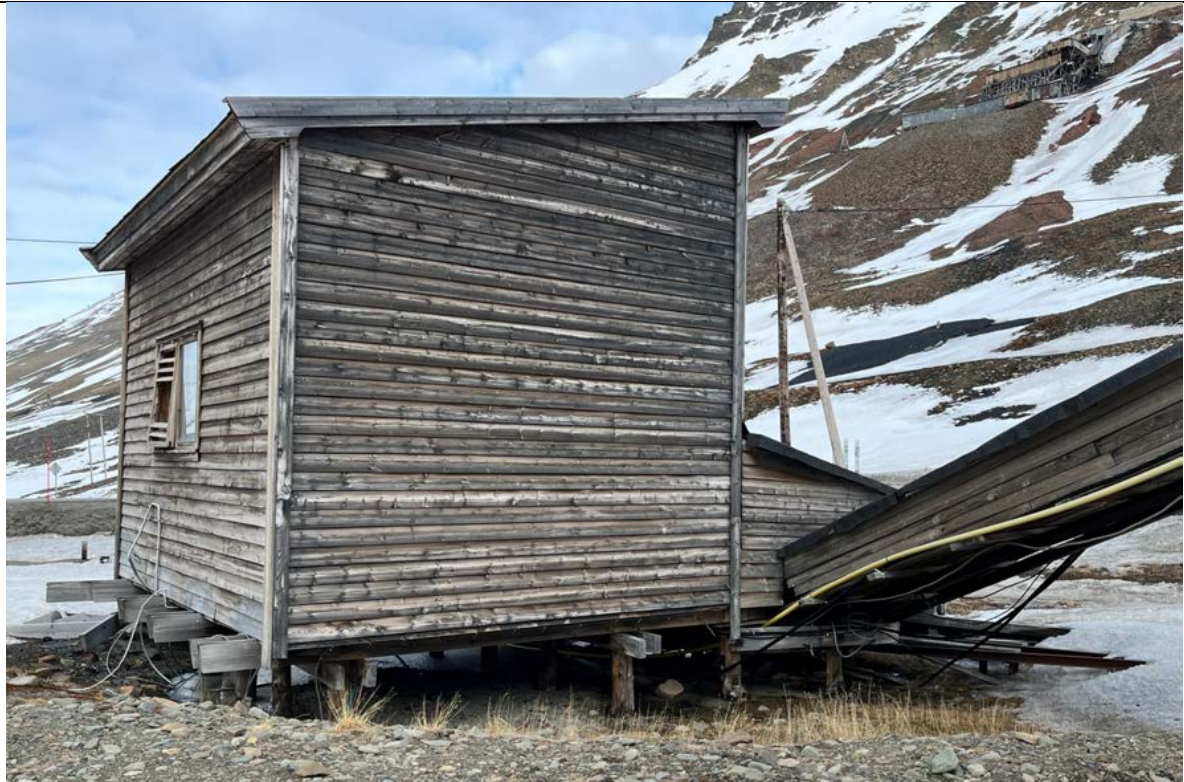
Pumpehuset sett fra sørvest, tett sørvegg og vindu/ventil mot vest. Bygningen er fundamentert på trepeler, forsterket med parstilte dragere av tre under bygningen. Rørgata går ut i retning Nybyen.
