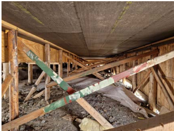
Peler med kryssavstivning under hovedbygget. Antatt etterisolert under dekket. Noen peler er trolig skiftet ut ved senere rehabilitering.
