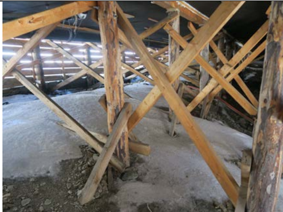
Eldre pelefundament med nyere kryssavstivning.
