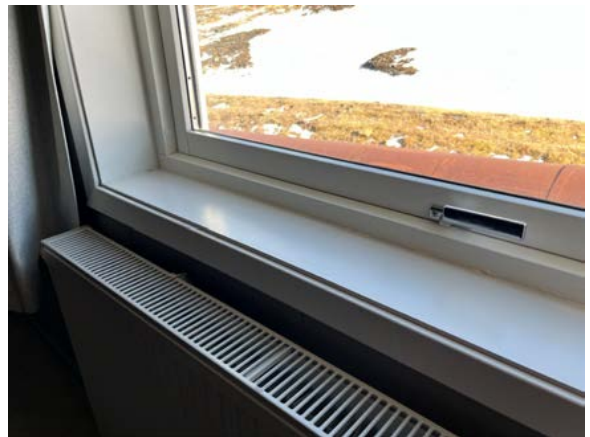
Typisk nyere isolerglassvindu. Radiatorene er fornyet.
