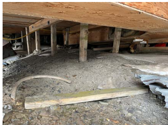
Bygningen er fundamentert på trepele.
