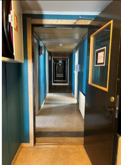
Midtkorridor i 1. etasje. Materialbruken er fra siste modernisering som studentboliger.
