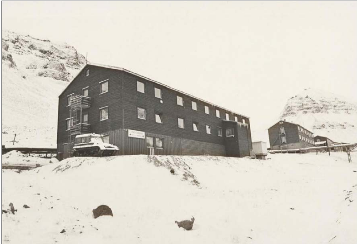
Formannsmessa med Røde Kors-skilt i kjelleren. Bygningens fasader, med ombygget hovedinngang med pulttak og veranda/rømningstrapp mot nord, framstår som i dag. Foto: Svalbardposten, udatert, etter 1998. nb.no
