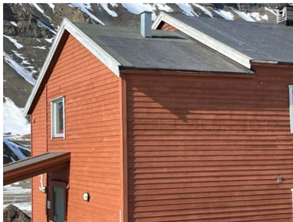
Tilbygget mot sør har lavere tak enn hovedbygningen. Kledningen går sømløst forbi tilbygg og hovedhus og ble fornyet samtidig med ombyggingen i 1970–74.
