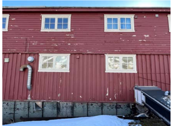
Fasade vest har lavere vinduer i begge etasjer, som opprinnelig. Opprinnelig karm og listverk er dels bevart, nyere isolerglassvinduer med opprinnelige ruteinndeling.
