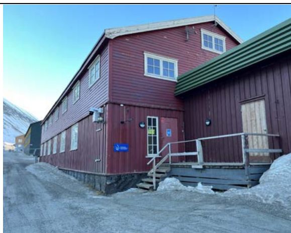
Tilbygg mot nord med nyere inngang i kortveggen, der det opprinnelig var et vindu.
