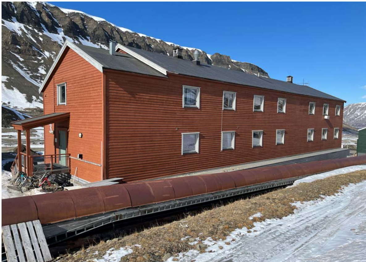
Fra sørøst. Kledningen går sømløst forbi trappetilbygget og er tilpasset ny vindusplassering etter ombyggingen i 1970–74. To opprinnelige luftelyrer til loftet er symmetrisk plassert på taket.
