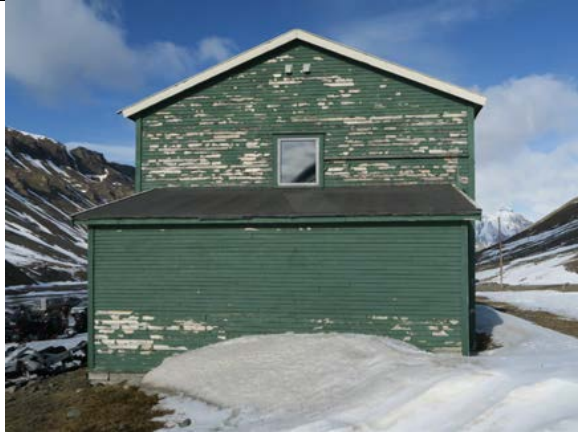
Opprinnelig utbygg mot sør. Det er skiftet panel i øvre del av veggen, trolig ble vinduer fjernet da.
