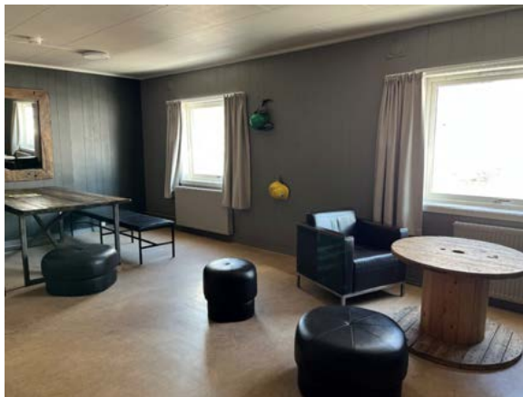
Opprinnelig fellesrom i 1. etasje mot øst. Alle kledningsmaterialer er fornyet ved siste rehabilitering.
