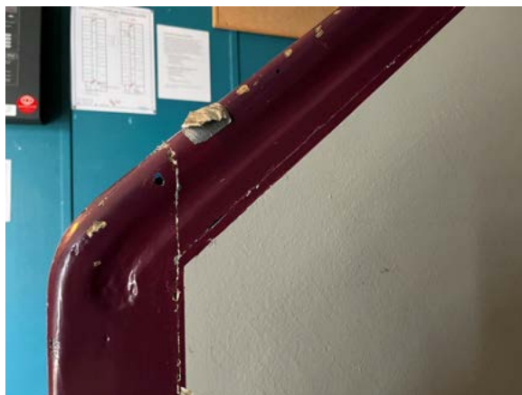
Detalj av trapprekkverk med fin buet profil og forsenkning på siden av håndløper.
