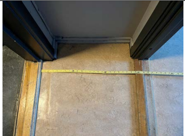
Den lille interne gangen mellom doble dører er ca. 60 cm bred. Løsningen er ikke opprinnelig.
