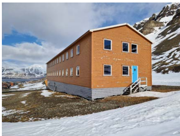
Gavl mot sør og langvegg mot vest.
