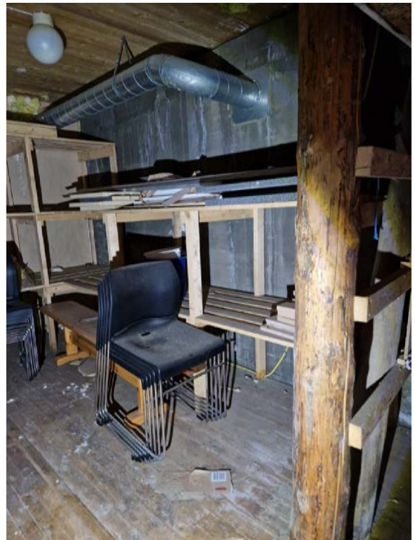
Innredet rom på bakkeplan. Betongvegg rett fram i bildet er vegg inn til tidligere fyrrom. Dette rommet ligger lengre sør, og tidligere fyrrom ligger helt mot nord som avslutning på hovedbygningen.
