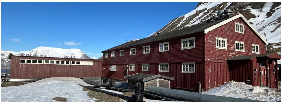
Fasade vest, tilbygg fra 1973 i bakgrunnen. Tre vinduer i 1. etasje er fjernet, ellers opprinnelige formater.
