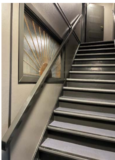
Opprinnelig trapperom fra 1. til 2. etasje, der flere opprinnelige detaljer er bevart.
