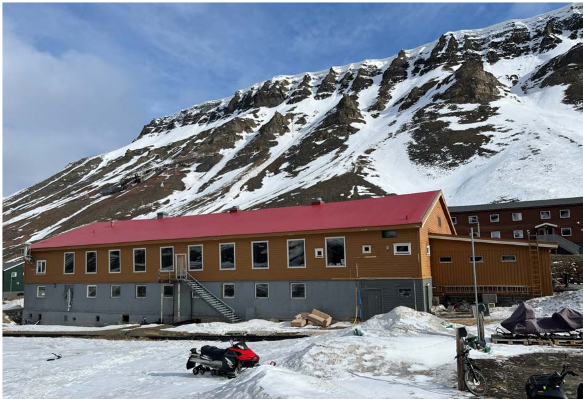
Fasade vest. Vinduene er skiftet til moderne sprosseløse typer, men plasseringen er lite endret. De store vinduene er inn mot den store spisesalen (messa).
