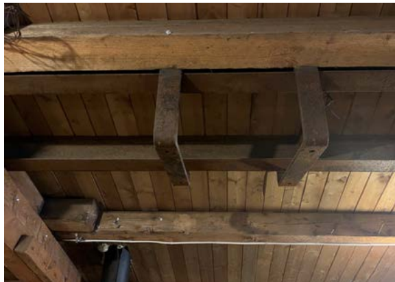
Heiseanordningen var festet med jern til takåsene.
