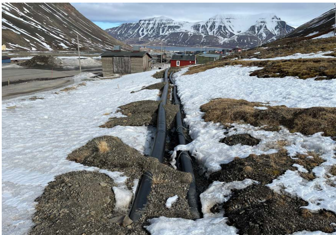
Delvis nedgravde rør i nordre del av rørgatestrekket, med Sandtørkeriet i bakgrunnen.
