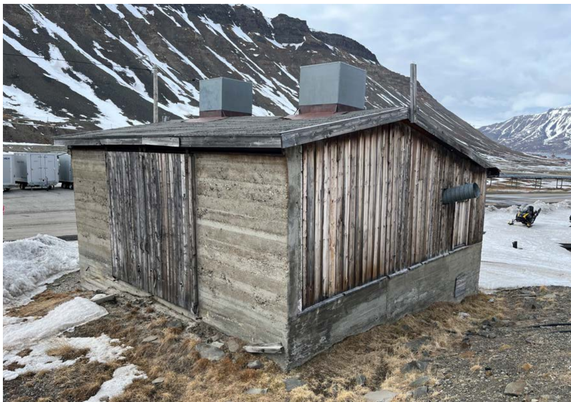
Fasade sør med dobbel port som kunne føres helt til siden, anhengt i ei jernskinne i øvre del av fasaden.
