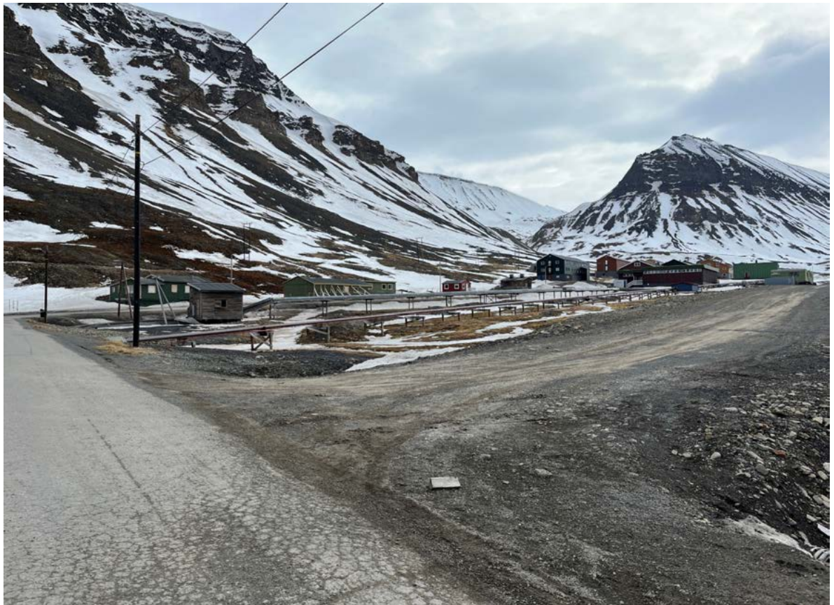
Nyere veiføring i vest nærmere elveleiet, antatt anlagt på 1970-tallet. Her med avkjøring fra Vei 300 mot Huset. Innkjøring til Nybyen i bakgrunnen.
