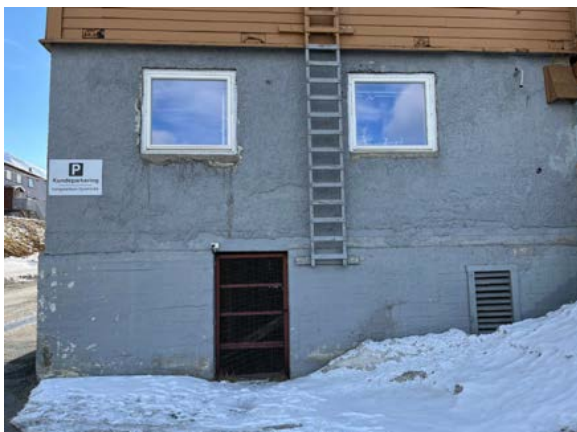
Støpt kjelleretasje er hevet opp på treper. Opprinnelig støpt skjørt, her med inngang under bygningen i nord.
