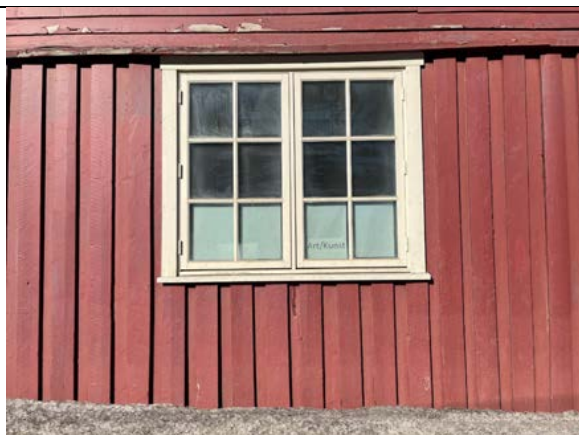
Typisk vindu i 1. etasje mot øst. Opprinnelig ruteinndeling er videreført i nye koblede isolerglassvinduer. Det er gjennomgående sprosser i ytre ramme.
