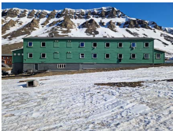
Langvegg mot vest. Fasaden er svært lite endret, fire blendete vinduer er markert i kledningen.
