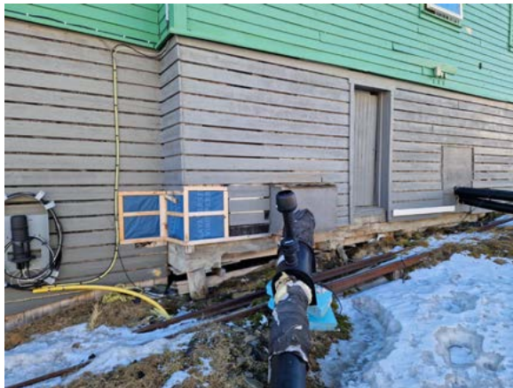
Langvegg vest ved overgang mot smalere utbygg nord. Betongvegg i tidligere fyrrom forsvinner opp bak skjørtet.
