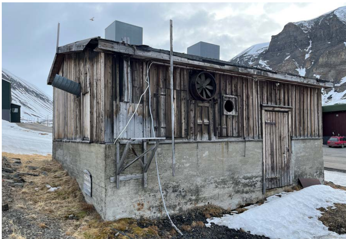
Fasade nord med inngangsdør, luker og vifte i vegg. Sandkasser sto på innsida av lukene.
