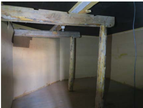
Et rom er etablert på bakkeplan mot nord under hovedbygget. Peler og dragere for bæring av av hovedbygget kommer midt i rommet.
