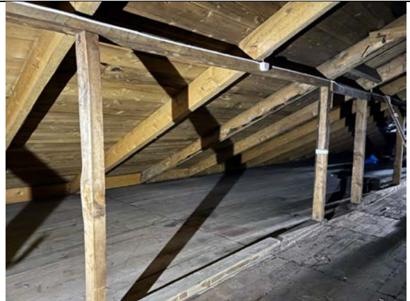
Sperrene understøttes av to langsgående bukker/stoler, som opprinnelig bygget.
