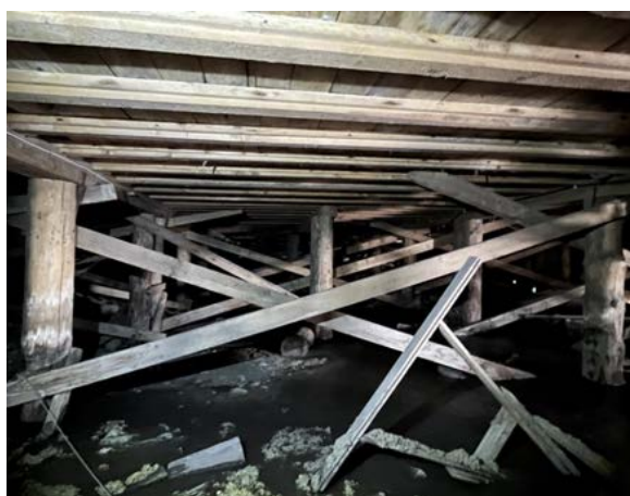
Opprinnelige pelefundamenter med en del nyere kryssavstiving. Etasjeskille av tre med stubbeloft.
