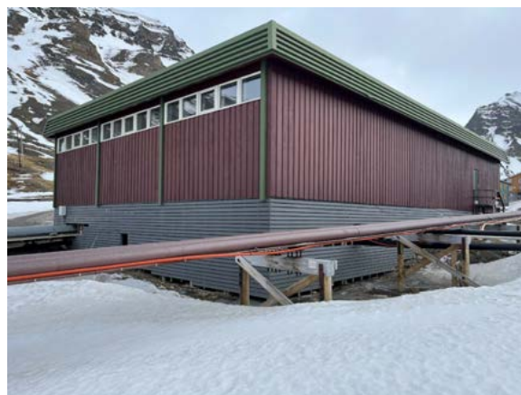
Fasade nord med vindusbånd, tett fasade vest.
