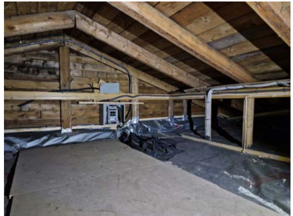
Spinklere bindingsverk med ytre supanel i gavl. Dekket mot 2. etasje er etterisolert.
