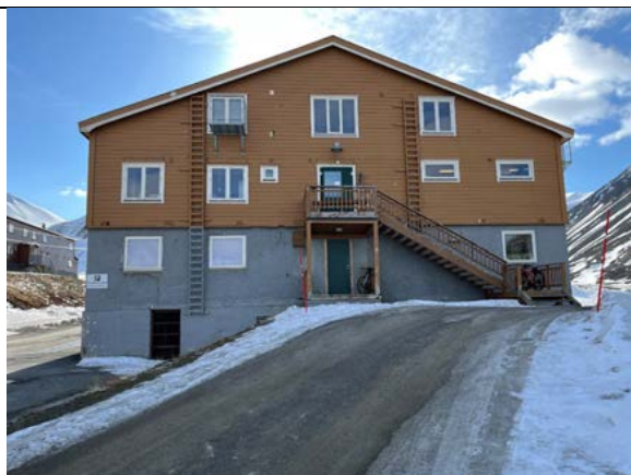
Fasade nord, dels nye vindusåpninger og utvendig trapp til den nyere leiligheten i loftsetasjen.
