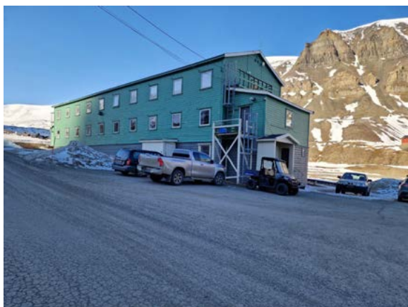
Langvegg mot øst og kortvegg mot nord med opprinnelig utbygg med pulttak.
