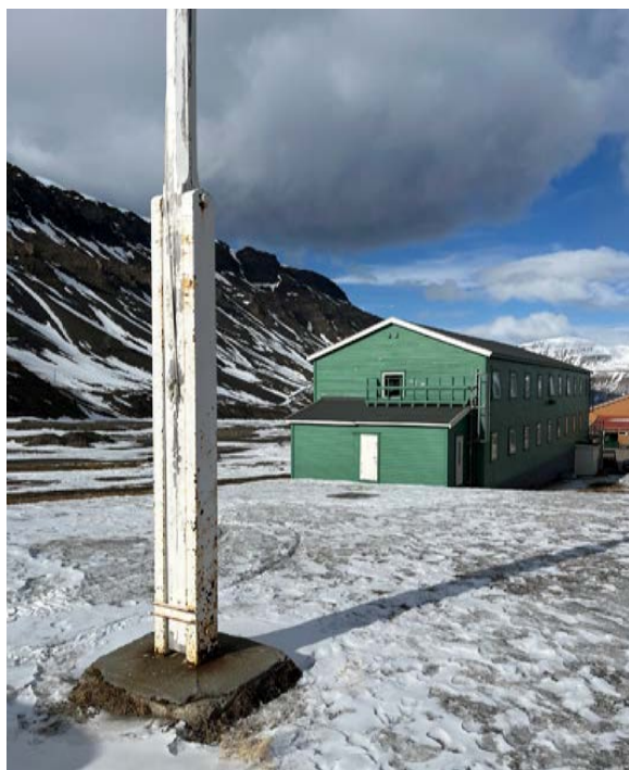
Flaggstang med tremast og sokkel av stål på støpt fundament. Tremastas nedre del er avfaset.
