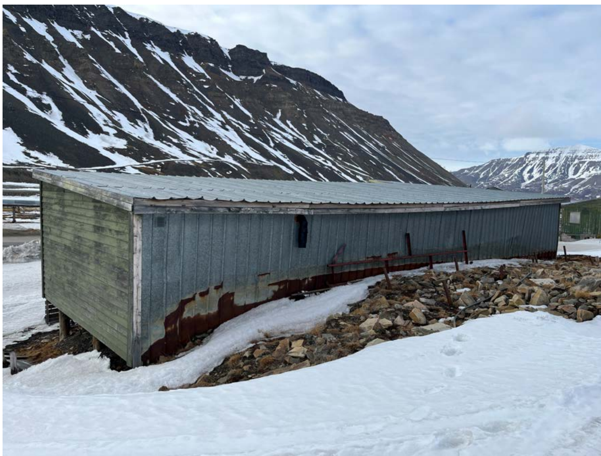
Det slake pulttaket og østveggen er kledd med korrugerte stålplater. Terreng/stein bygger seg opp.
