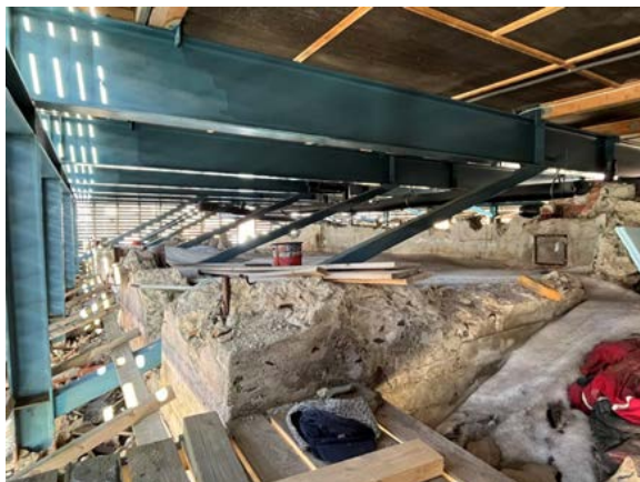
Stålkonstruksjonen spanner over restene av opprinnelig støpt kjeller/fyrrom.
