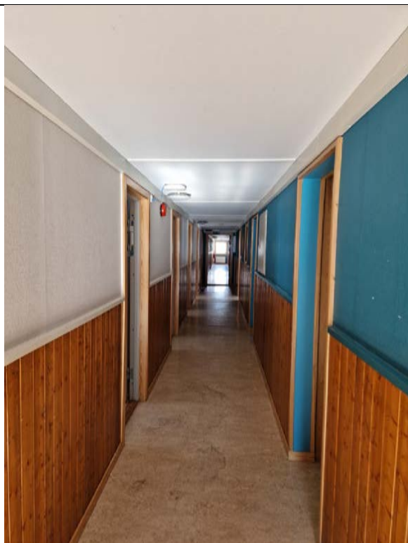
Korridor 2. etasje. Eldre brystningspanel.
