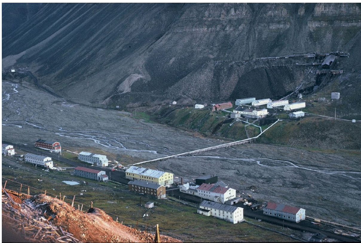
Nybyen 29. juli 1974. Flere større moderniseringer er nylig utført, blant annet ser vi dette uttrykt ved nye tilbygg på Buret og brakke 102. Det nye fyrhuset vest for Badet er nylig oppført. (Transformatorkiosken øst for Buret har et tilbygg mot øst.) Foto: Pål Skaare / Gunnar Halden, Svalbard museum SVF 05715.
