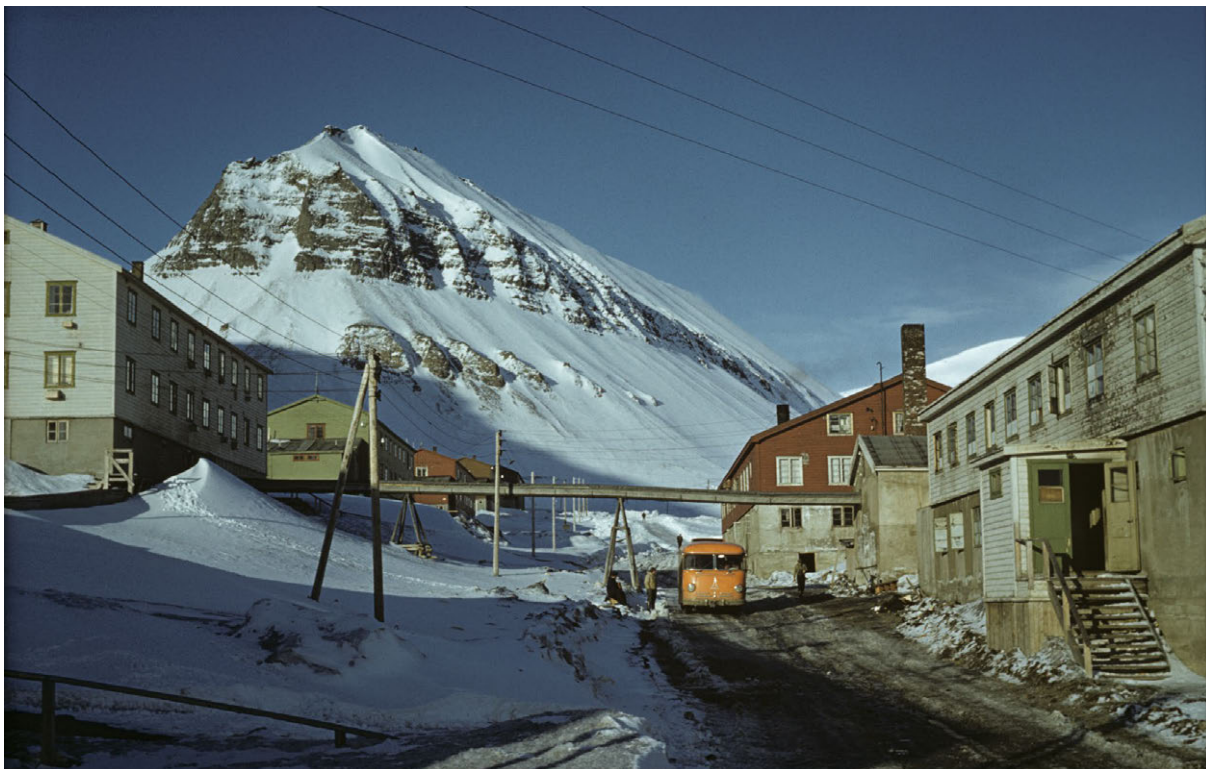
Bad/fyrhus til høyre, rørgate over til Buret. Foto: Erling Johan Nødtvedt 1959. Svalbard museum SVF 09622
