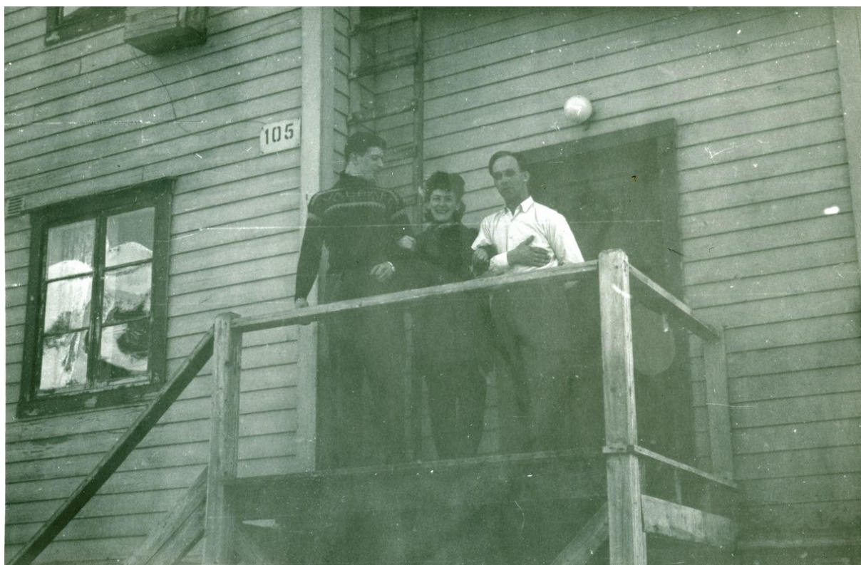
Inngang til typisk boligbrakke (nr. 105 er nå revet). Fasadene har supanel og enkle hjørnekasser. Listverket rundt vinduene er enkle bord med skrå vannbrett over vinduet. Hovedinngangen lå i utbygget, med enkel tretrapp fra terreng opp til 1. etasje. Rømningsstige av tre er montert på veggen, for mulig evakuering fra 2. etasje over utbygget. Foto: Johan Erling Nødtvedt 1958, Svalbard museum SVF 08945
