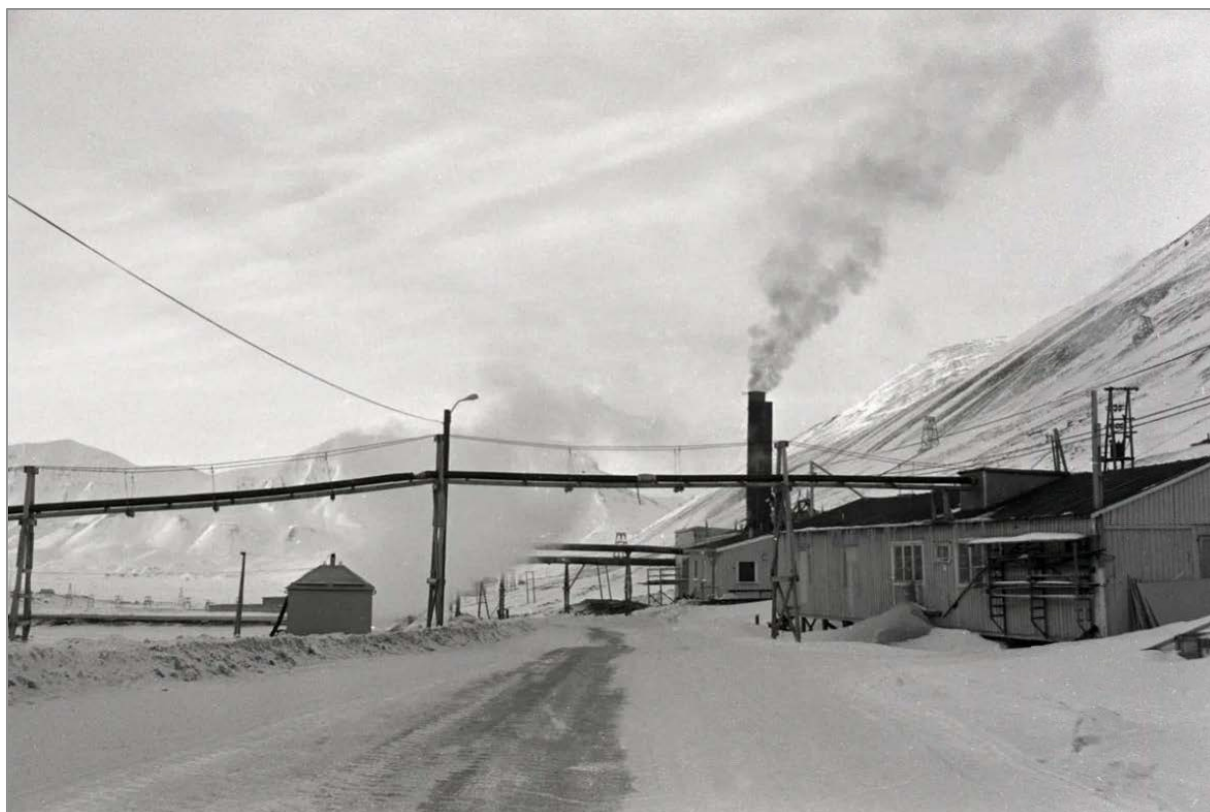
Bildet er trolig fra begynnelsen av 1970-tallet, med fyrhuset i full drift. Vaktmesterverkstedet er oppført nord for Snekkerverkstedet. Den lille bygningen t.v. er ukjent, likeså rørgata som går inn i et takoppløft på Snekkerverkstedet. Foto: ukjent, Svalbard museum, SVF 25017
