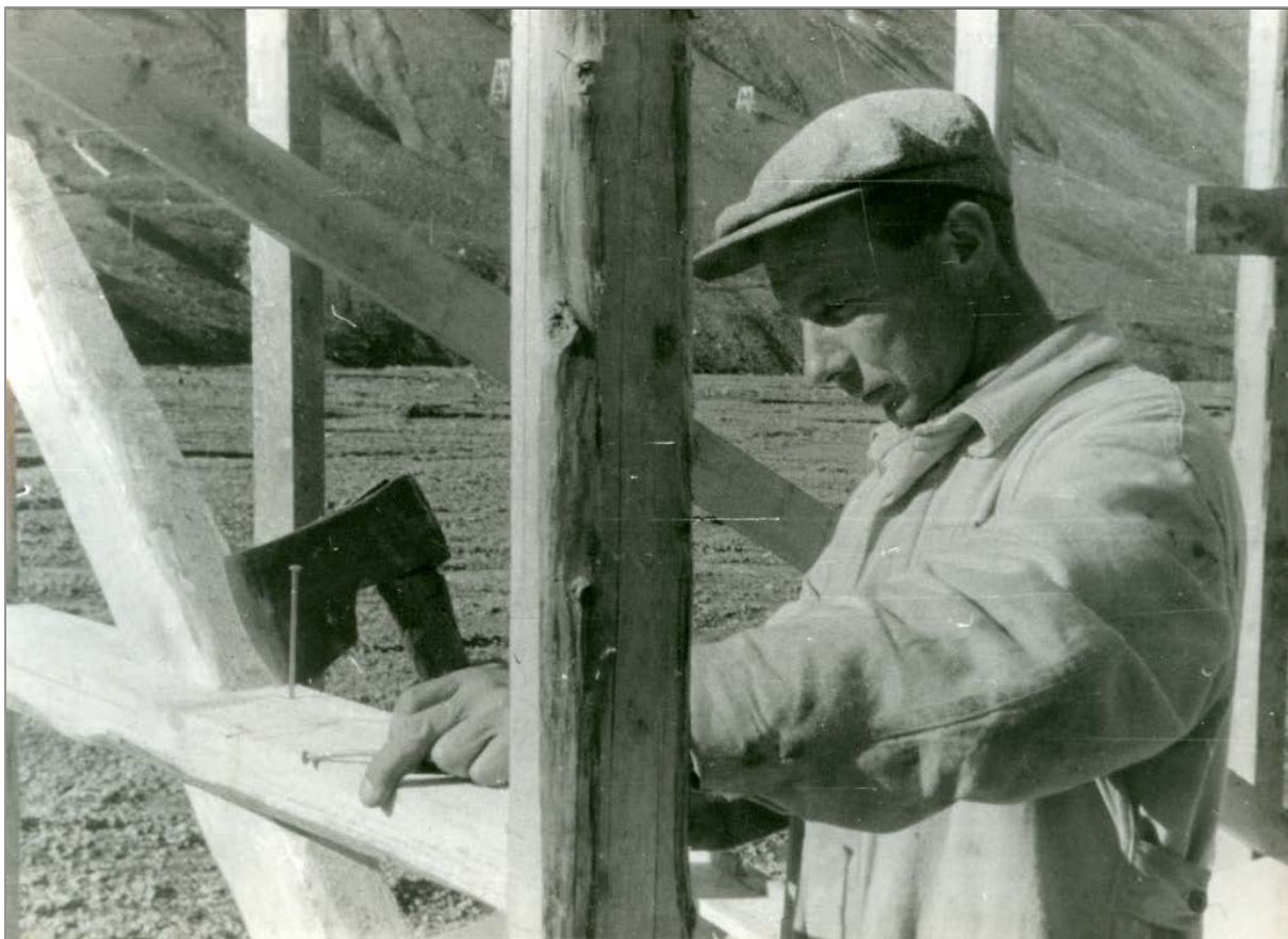
Bygging av vegger av tungt bindingsverk med noe skråavstiving. Stenderne har delvis barkkant, og tradisjonelle tømmerforbindelser lages med øks. Foto: Claus Stordal 1946, Svalbard museum SVF 46917
