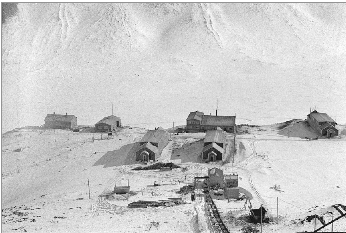
Sverdrupbyen sett fra Gruve 1B i 1941. Bebyggelsen ble påbegynt før krigen, men ikke fullført, i henhold til en reguleringsplan fra 1938. Tre arbeiderbrakker og Arbeidermessa er oppført, samt en funksjonærbolig og en lagerbygning mot nord (til venstre). Foto: Einar Dorenfeldt Jenssen. Svalbard museum SVF 46846
