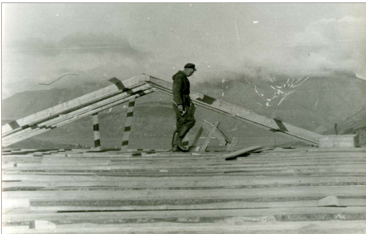
Taksperrene reises. Sammenføyningen ved mønet er her forsterket med spikerplater, tilsvarende ses på de fleste loftene i dag (ref. brakke 102). Foto: Claus Stordal 1946, Svalbard museum SVF 46967
