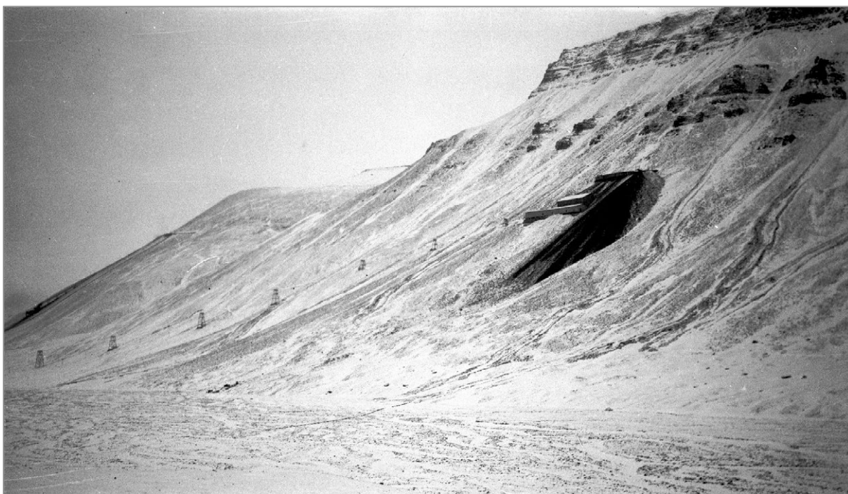
Nytt utslag med daganlegg ved H2N i 1937, med taubanen som krysset elvedalen mot Taubanesentralen på Skjæringa. Foto Sigurd Westby, Svalbard museum SVF 46452
