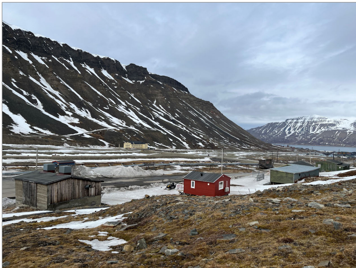
Sandtørkeriet t.v. og de grønnmalte verkstedbygningene nord i Nybyen. Ved veikrysset mot Huset ses det umalte Pumpehuset med rørgate. (Rødmalt hus er det nyere Musikkstudioet.)
