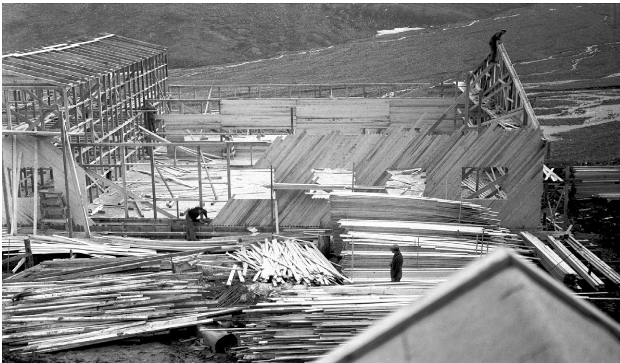
Bygging av Arbeidermessa i Sverdrupbyen i juli 1939. Skråstilt rupanel spikret rett på bindingsverket bidrar til å avstive ytterveggene. Foto: Sigurd Westby, Svalbard museum, SVF 46251
