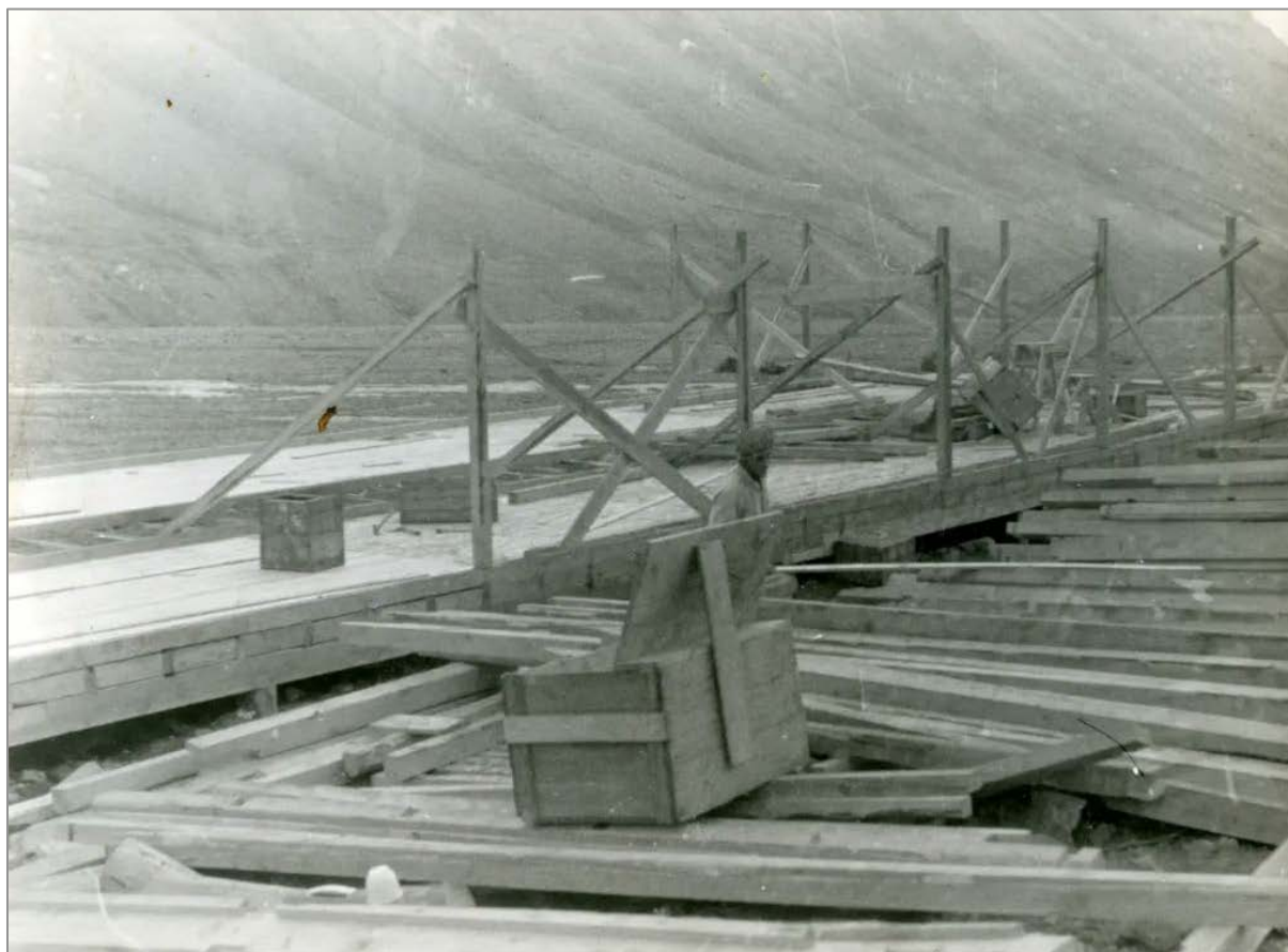
Fundamentet bygges. Kraftige peler av rundtømmer er slått ned i bakken. Tre høyder med sviller (med hakeskjøter) danner anlegg for etasjeskille/bjelkelag mot grunnen og vegger. Foto: Claus Stordal 1946, Svalbard museum SVF 46918 (t.h.) og SVF 46916 (under)
