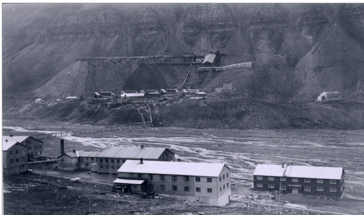
I forgrunnen ses Formannsmessa med det nye tilbygget mot nord fra 1951 (forlengt med to vindusakser). Det lave utbygget mot sørøst er fra byggeåret 1947. Foto: Wilhelm Solheim, Norsk Polarinstitutt NP002990
